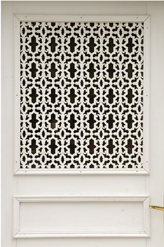
Bâtiment 62-64 rue des Forges : ferronnerie d'une porte (62 rue des Forges). 25, Jougne
