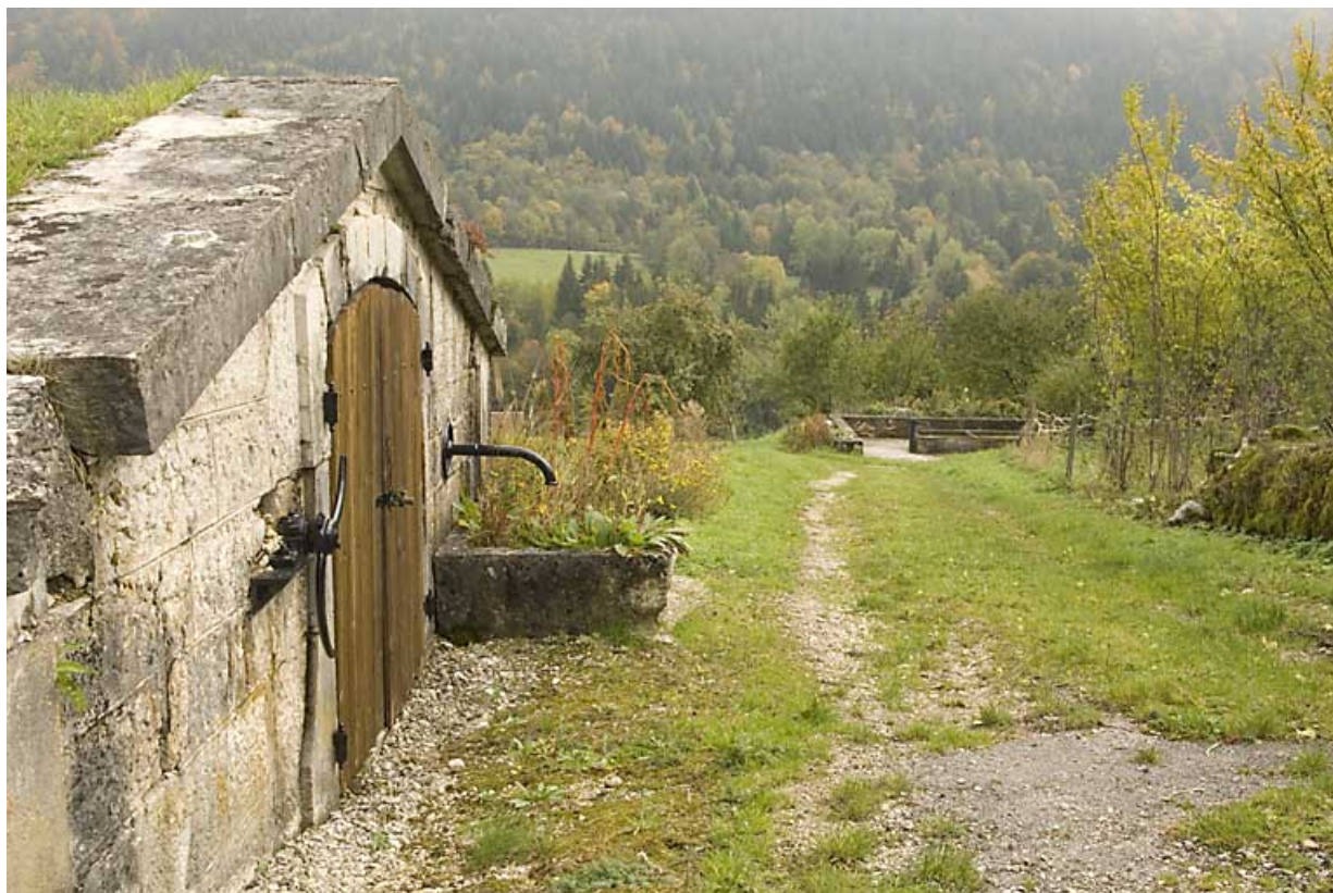
Réservoir des Maillots : façade vue en enfilade. 25, Jougne
