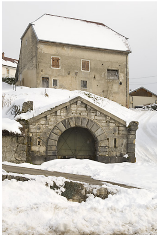
Réservoir des Portes, en hiver.
