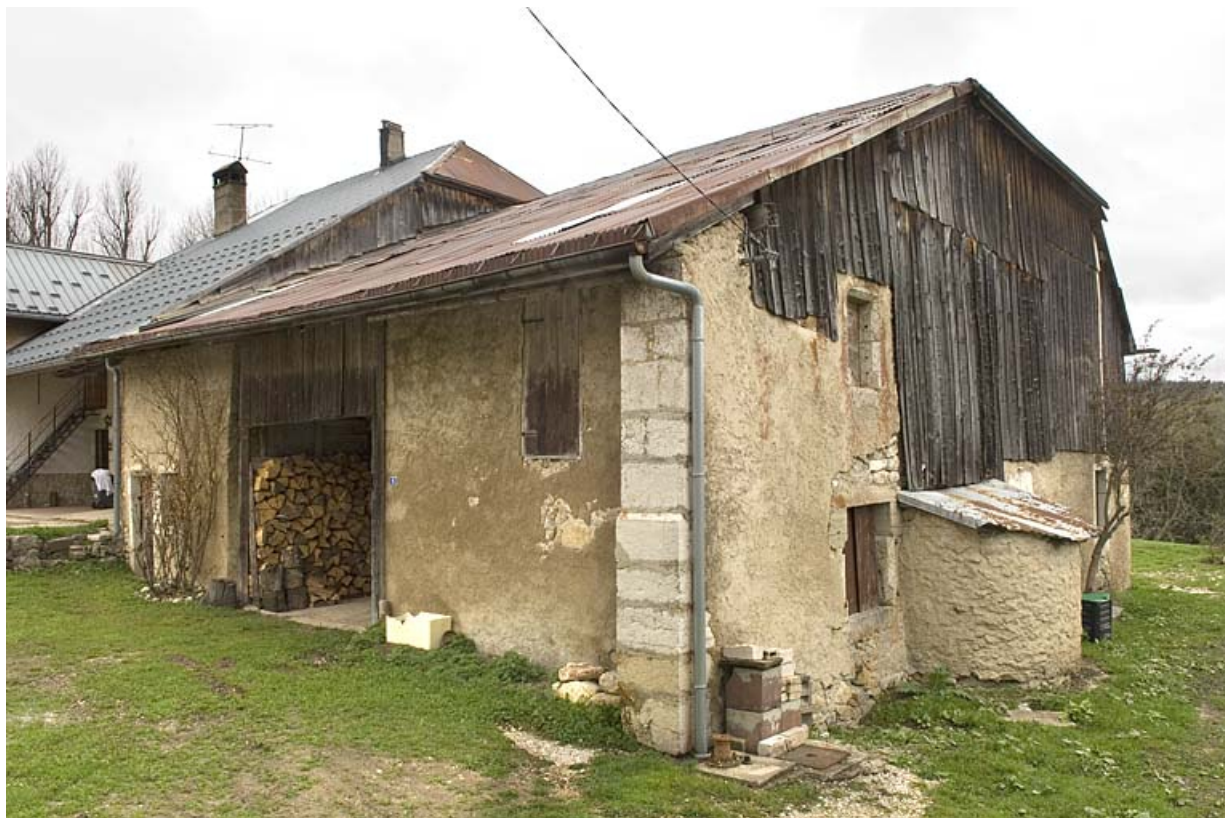
Ferme rue de Jougne (Entre-les-Fourgs, 2020 AD 173), avec avant-toit, mur pare-vent, cache-bois, talvane et four à pain en saillie sur la façade latérale.
