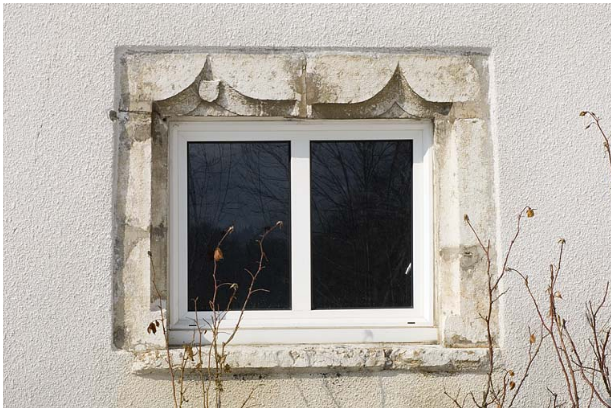
Ferme à Entre-les-Fourgs : baie du 16e siècle. 25, Jougne
