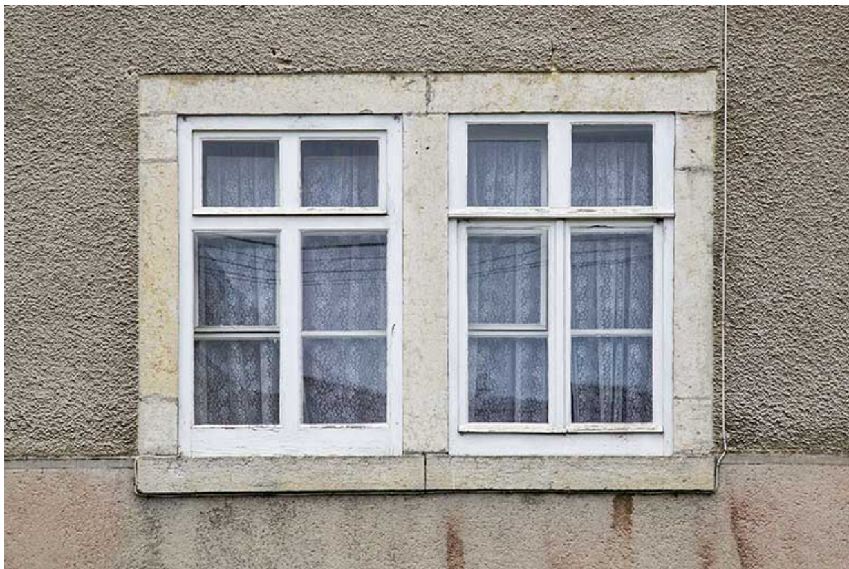
Une fenêtre horlogère ou "pile double" : atelier d'horlogerie de Louis et Léon Feuvrier puis de Robert Bessot (16 Grande Rue). 25, Charquemont, 16 Grande Rue
