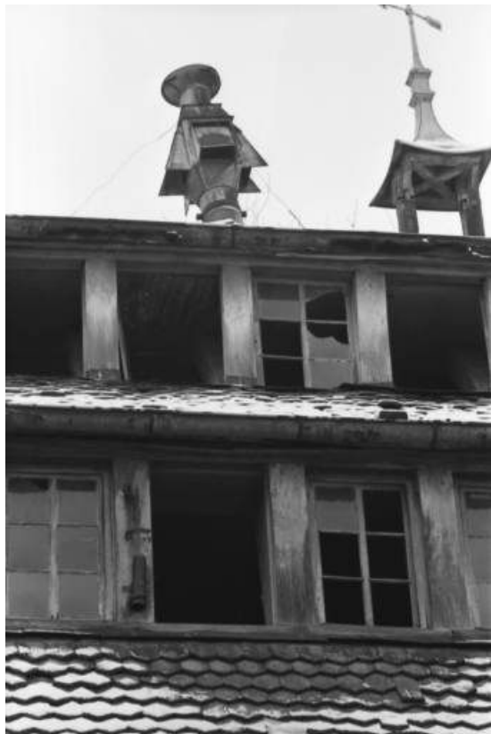
Détail des étages supérieurs de l'atelier d'horlogerie en 1979.
