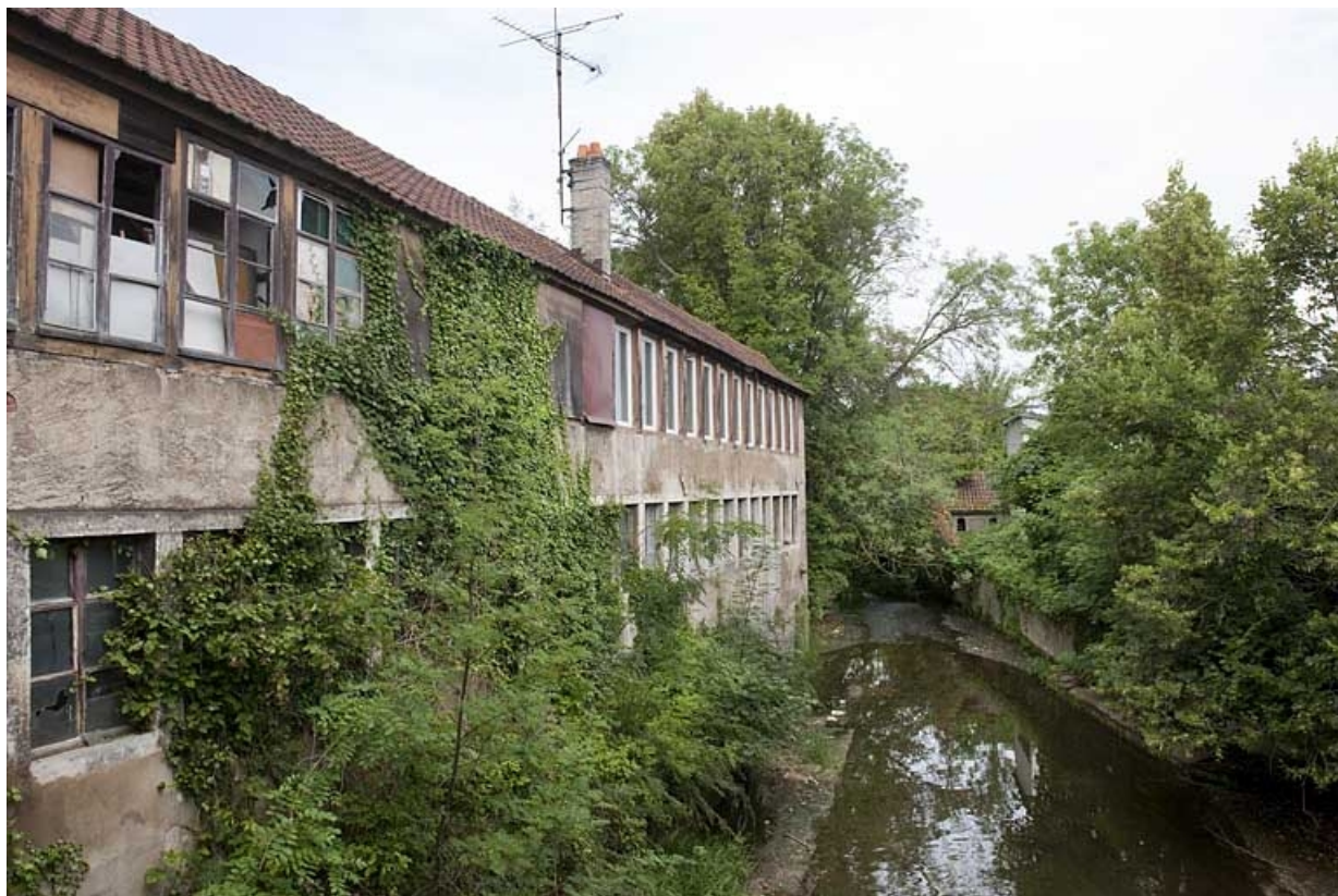
Façade est de l'atelier d'horlogerie depuis le passage couvert.
