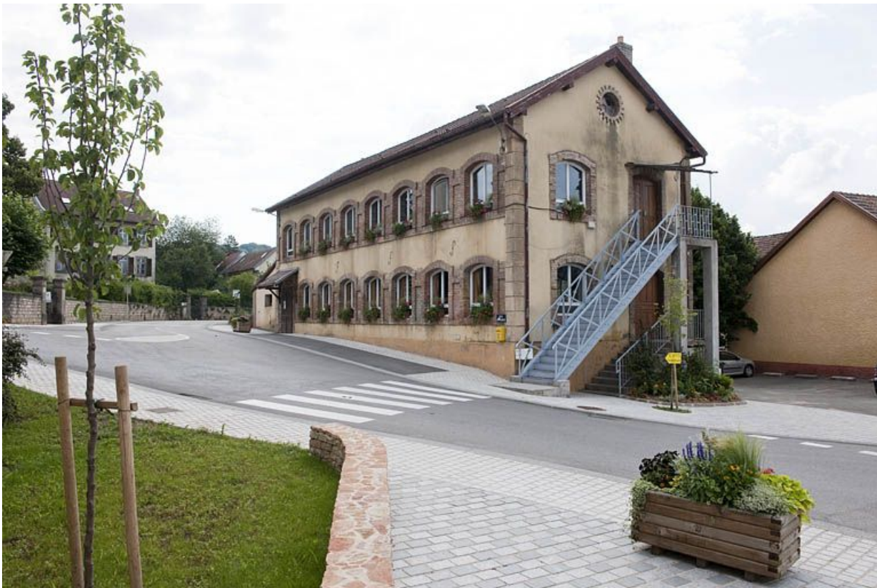
Vue rapprochée depuis l'ouest.
