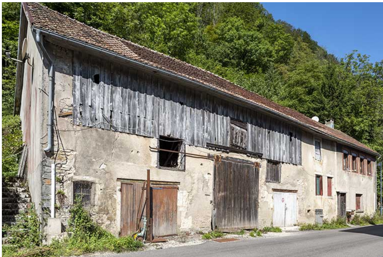
Logement occidental : façade antérieure, de trois quarts gauche. 25, Saint-Hippolyte rue du Dessoubre
