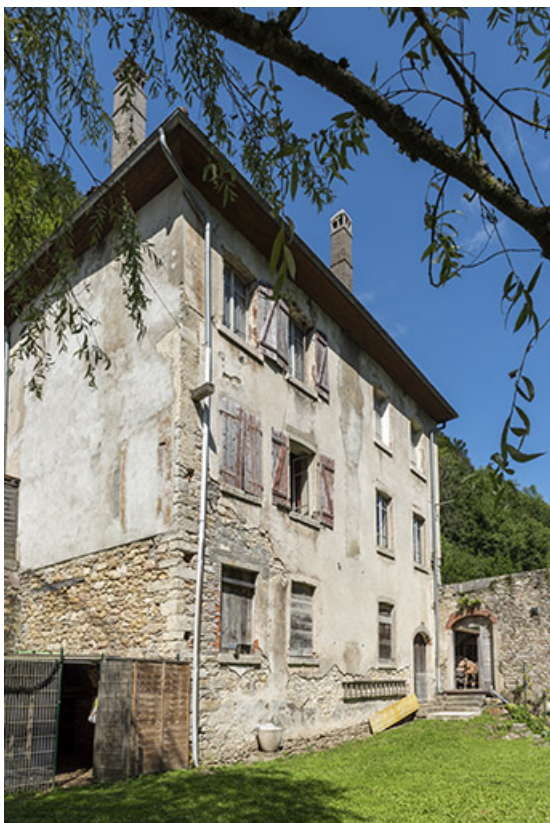
Logement : élévations postérieure et latérale droite. 25, Saint-Hippolyte rue du Dessoubre
