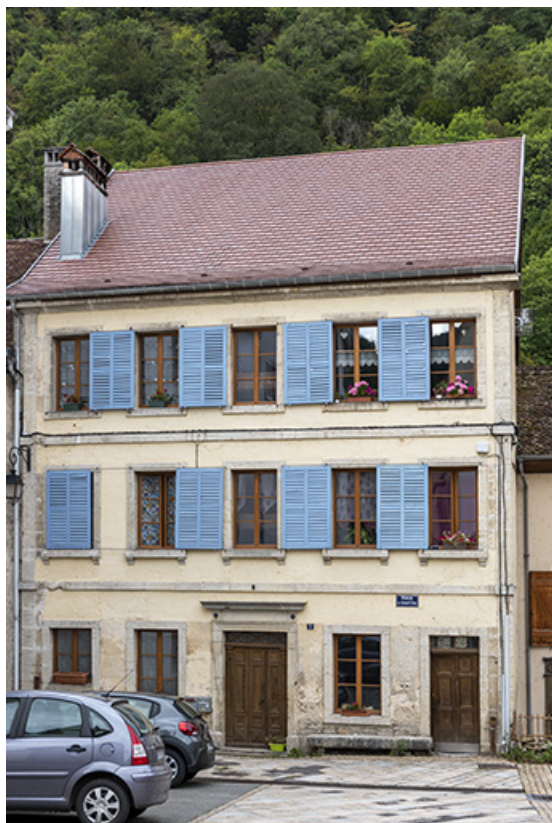
Immeuble 3 place du Chapitre : façade antérieure.
