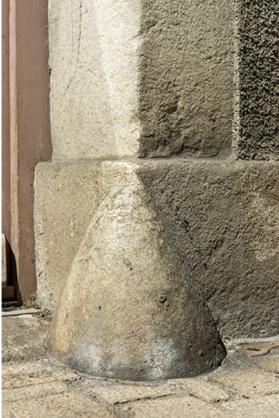
Immeuble 2 rue Jacques Courtois : chasse-roue.
