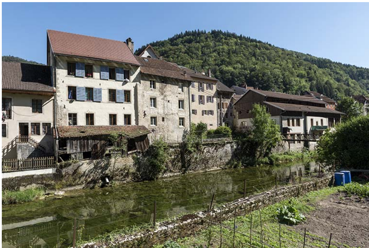
Vue d'ensemble, depuis le nord-ouest. Bâtiments place du Chapitre et 2 impasse de la Tannerie à gauche, tannerie à droite. 25, Saint-Hippolyte, 2-4 impasse de la Tannerie
