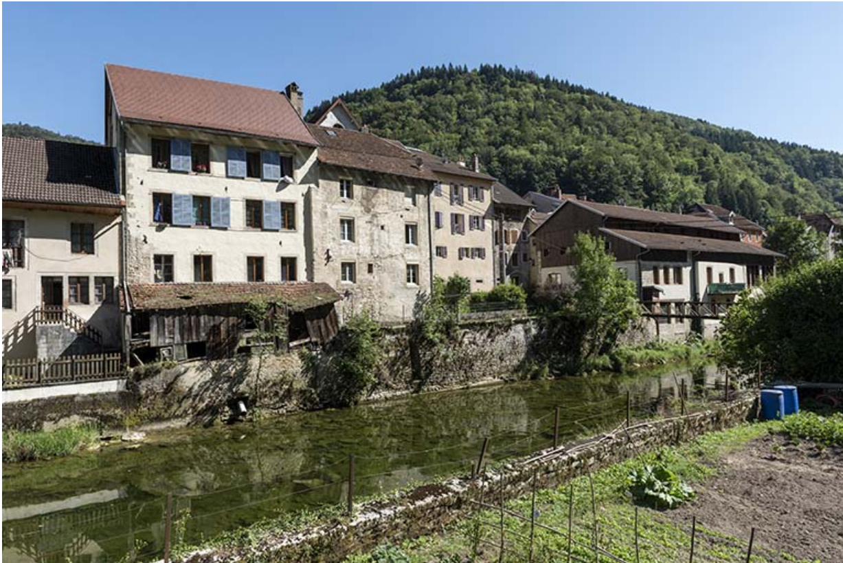
Vue d'ensemble, depuis le nord-ouest. Bâtiments place du Chapitre et 2 impasse de la Tannerie à gauche, tannerie à droite. 25, Saint-Hippolyte, 2-4 impasse de la Tannerie
