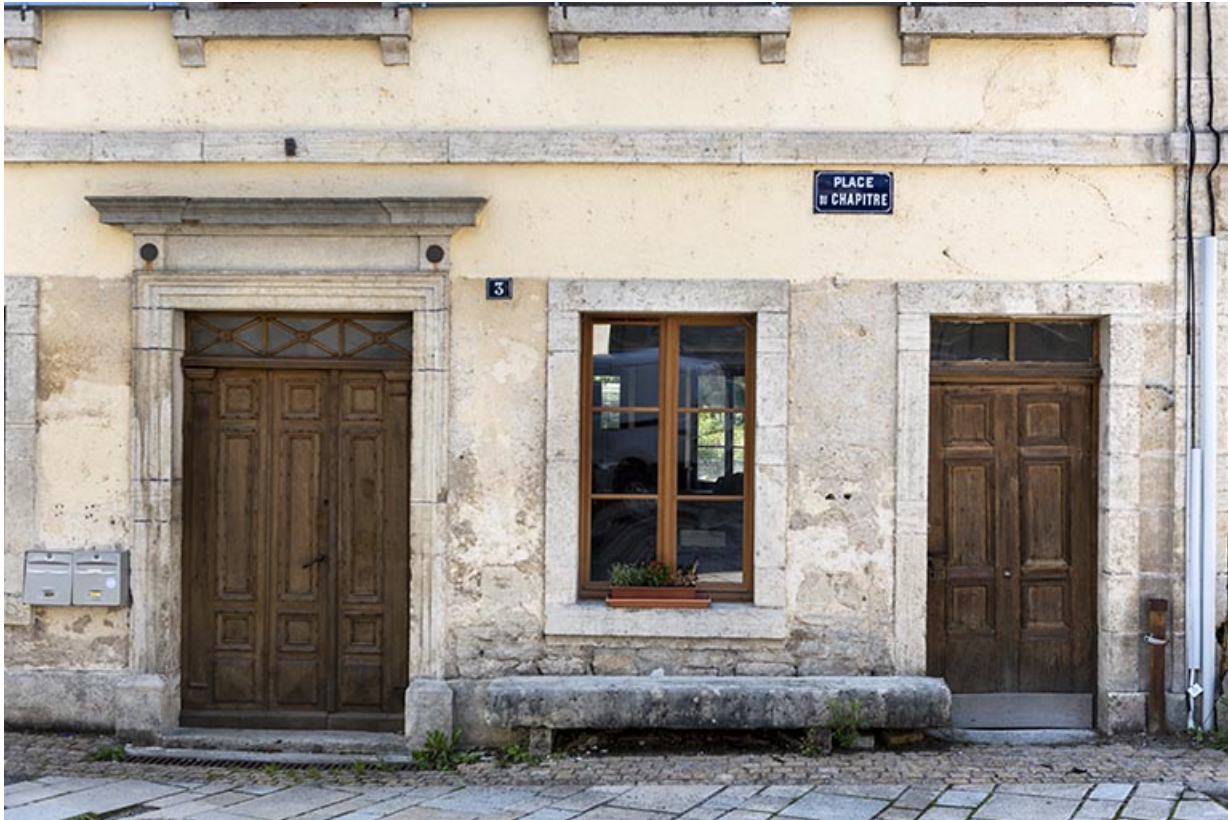
Immeuble 3 place du Chapitre, façade antérieure : entrée.
