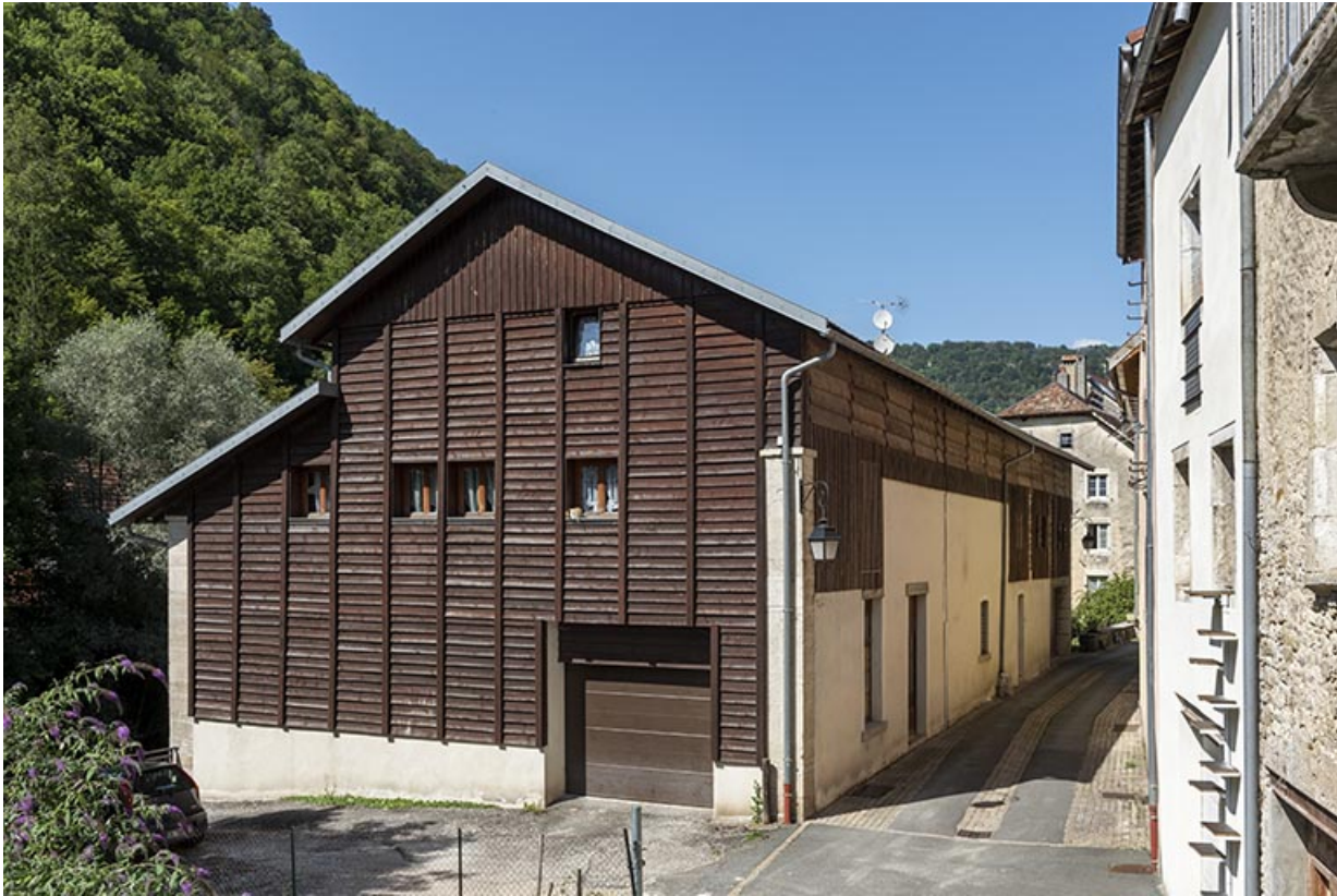
Tannerie : façades postérieure et latérale gauche.
