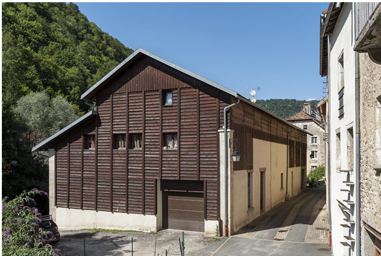
Tannerie : façades postérieure et latérale gauche.
