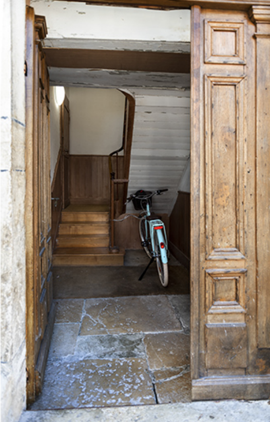
Immeuble 3 place du Chapitre, façade antérieure : vestibule et escalier. 25, Saint-Hippolyte, 2-4 impasse de la Tannerie
