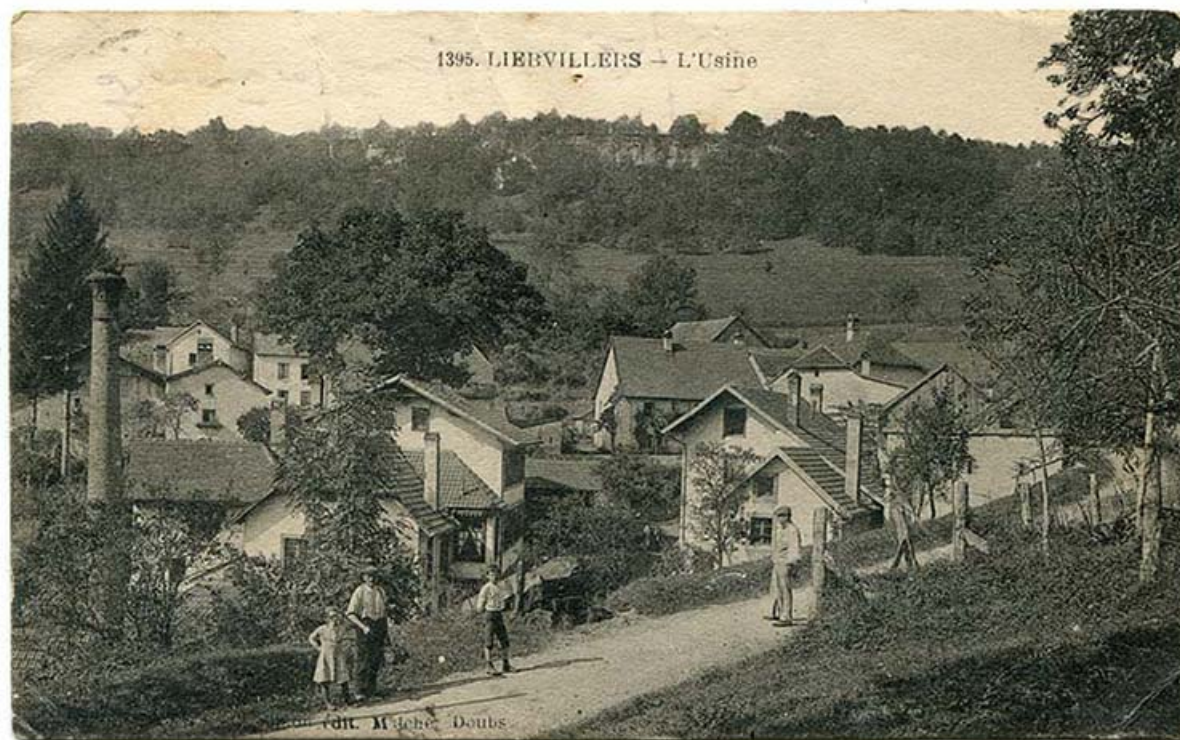
1395. Liebvillers - L'usine, 1ère moitié 20e siècle [avant 1932].
