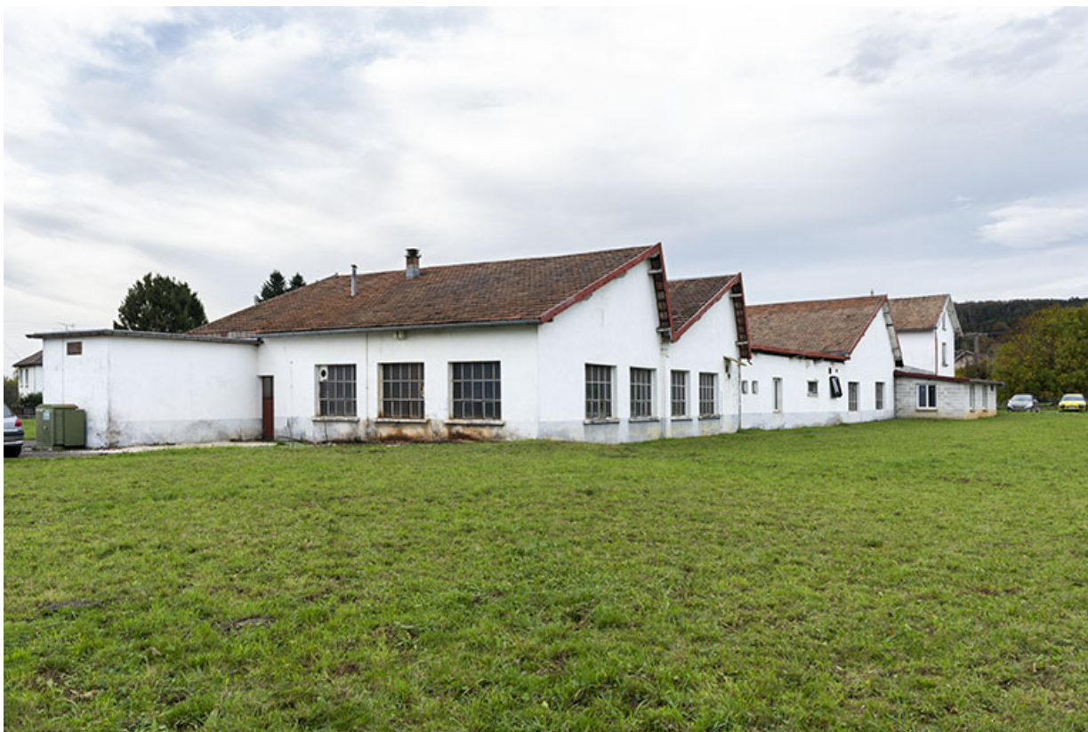
Vue d'ensemble, depuis le sud-est (façade latérale gauche). 25, Montécheroux, 18 rue de la Pâle
