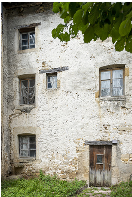
Maison : façade postérieure, de trois quarts.
