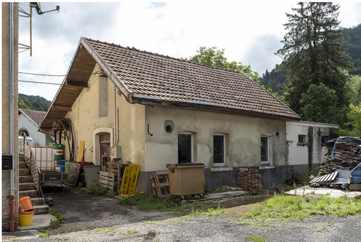
Façades antérieure et latérale droite.
