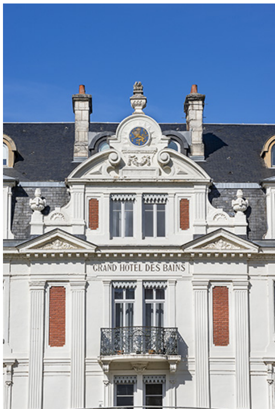
Façade sur le jardin, travées centrales, détail.
