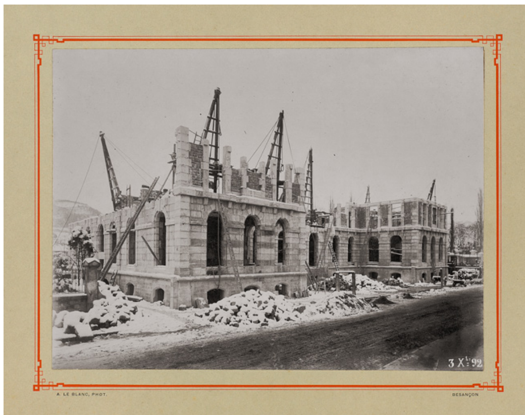
Chantier de construction (3 décembre 1892). 25, Besançon, 2 avenue Carnot
