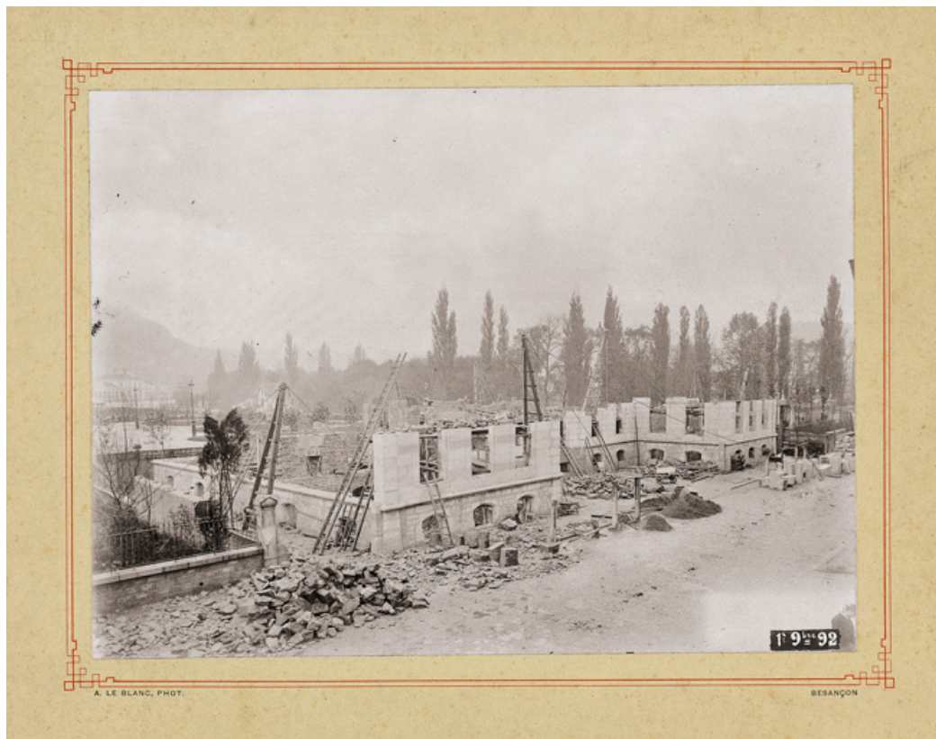
Chantier de construction (1er novembre 1892).
