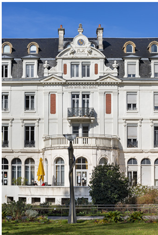
Façade sur le jardin, travées centrales.
