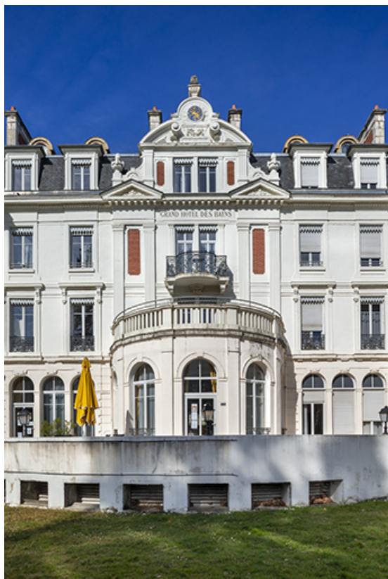
Façade sur le jardin, travées centrales.
