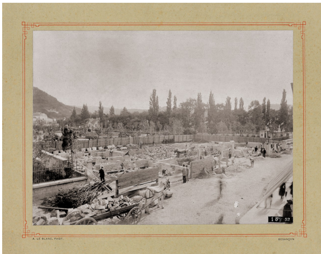
Chantier de construction (1er octobre 1892). 25, Besançon, 2 avenue Carnot
