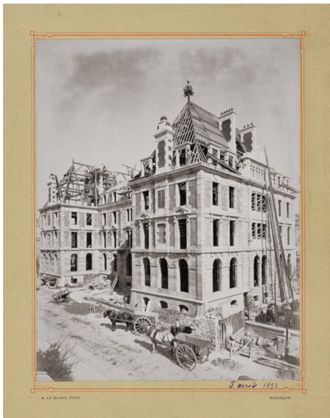
Chantier de construction (5 avril 1893). 25, Besançon, 2 avenue Carnot
