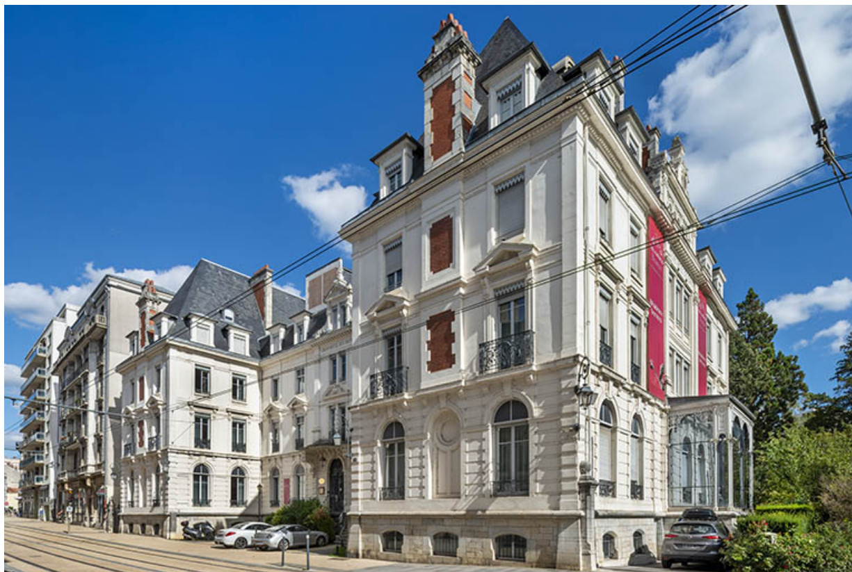
Vue d'ensemble depuis l'avenue Carnot. 25, Besançon, 2 avenue Carnot
