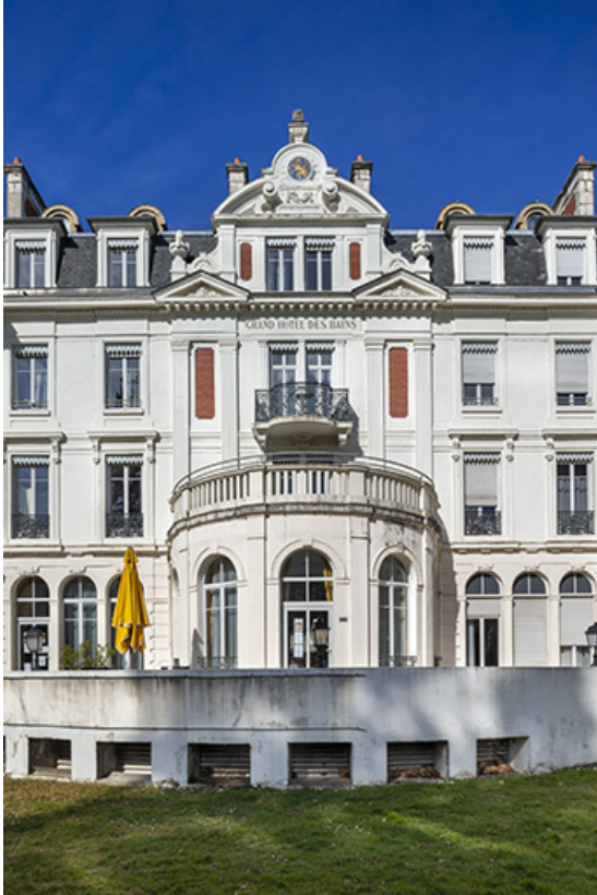
Façade sur le jardin, travées centrales.
