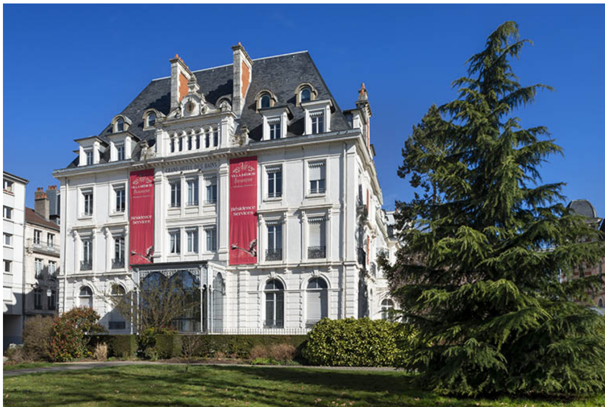
Façade sur l'avenue Édouard Droz.
