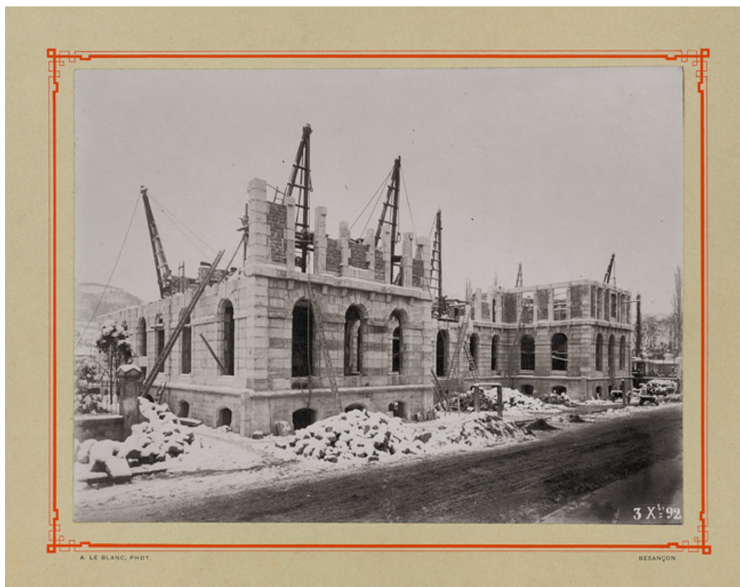
Chantier de construction (3 décembre 1892). 25, Besançon, 2 avenue Carnot
