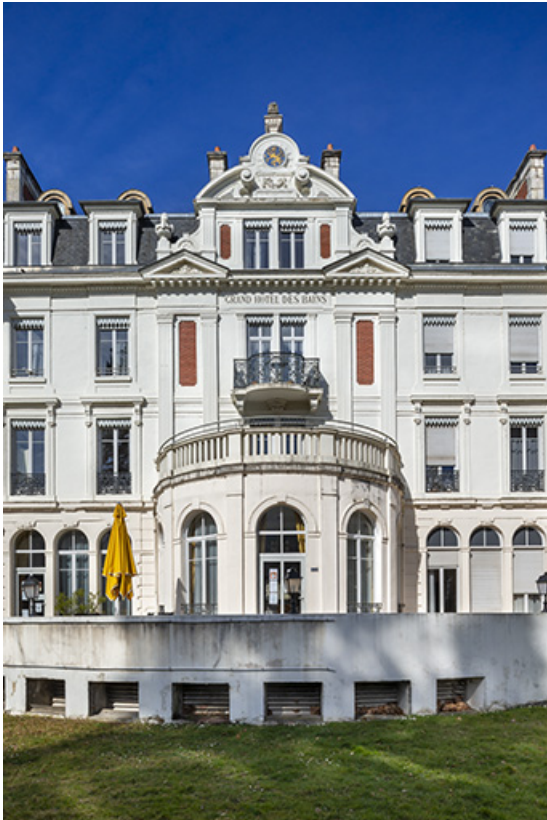
Façade sur le jardin, travées centrales.
