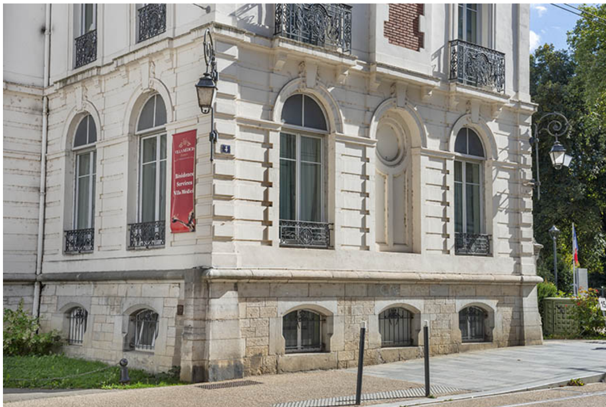
Façade sur l'avenue Carnot, avant-corps de droite, détail du niveau de soubassement. 25, Besançon, 2 avenue Carnot
