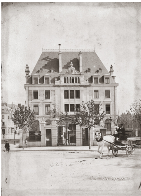
Façade sud (vers 1893). 25, Besançon, 2 avenue Carnot
