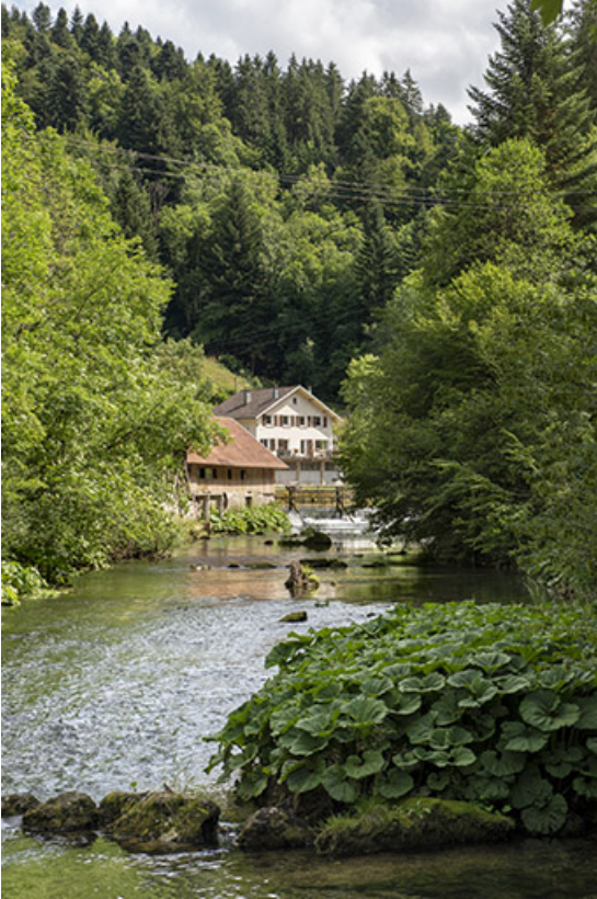
Vue d'ensemble depuis le Dessoubre, en aval. 25, Plaimbois-du-Miroir, lieudit : le Moulin Girardot
