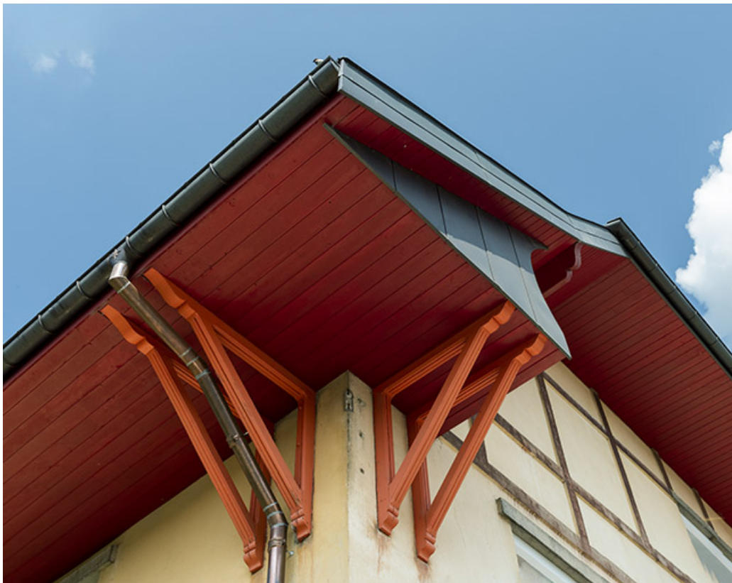
Consoles soutenant l'avant-toit.
