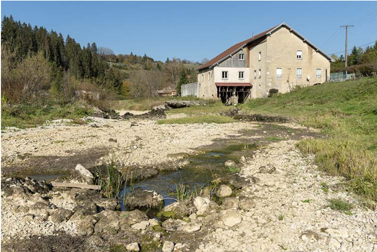
Moulin : vue d'ensemble depuis le sud (amont), avec le Doubs à sec.
