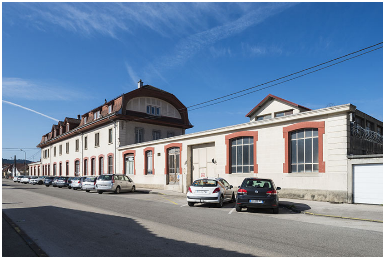
Vue de trois quarts des bâtiments rue des Ecoissons.
