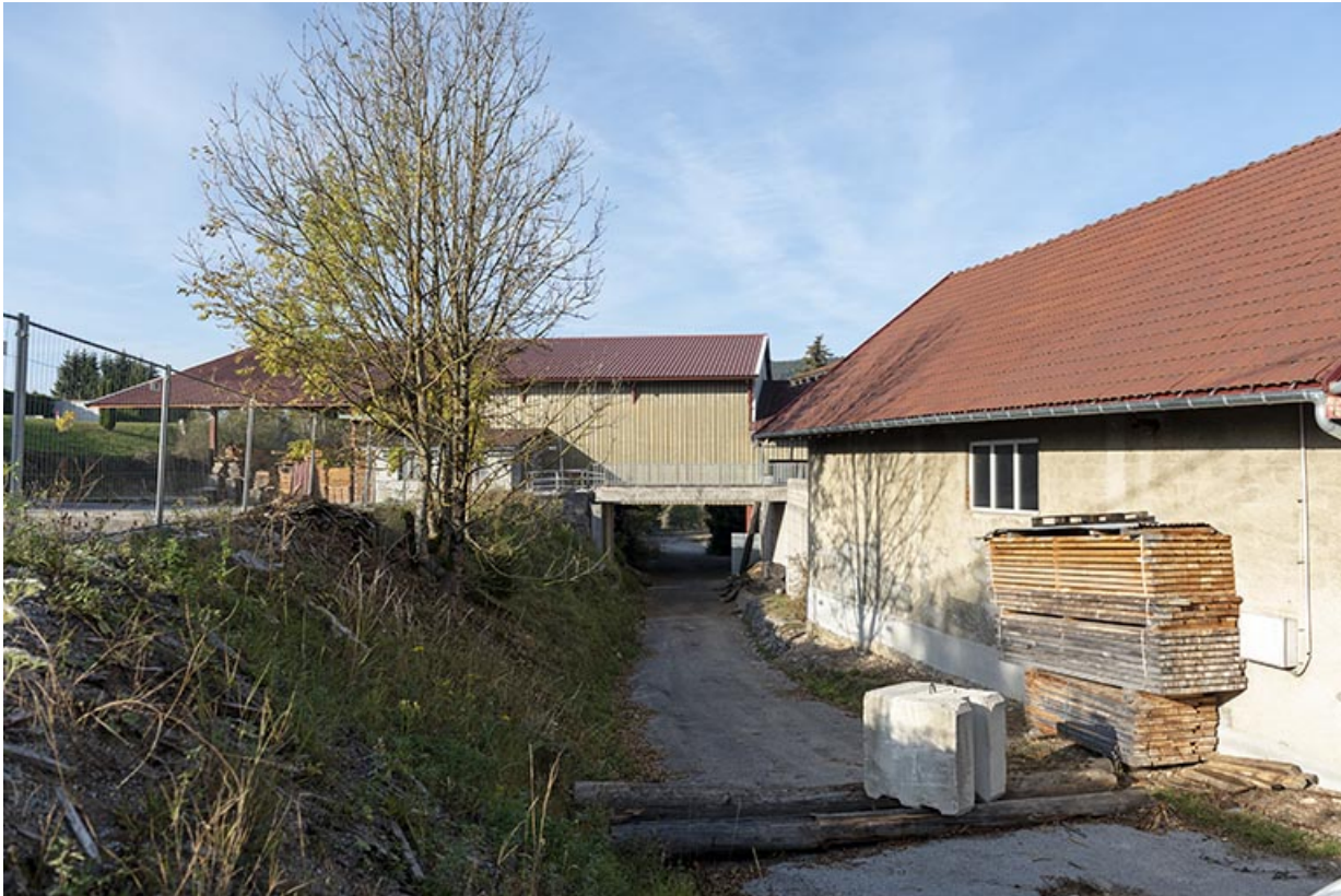
Atelier récent et chemin, depuis l'est.
