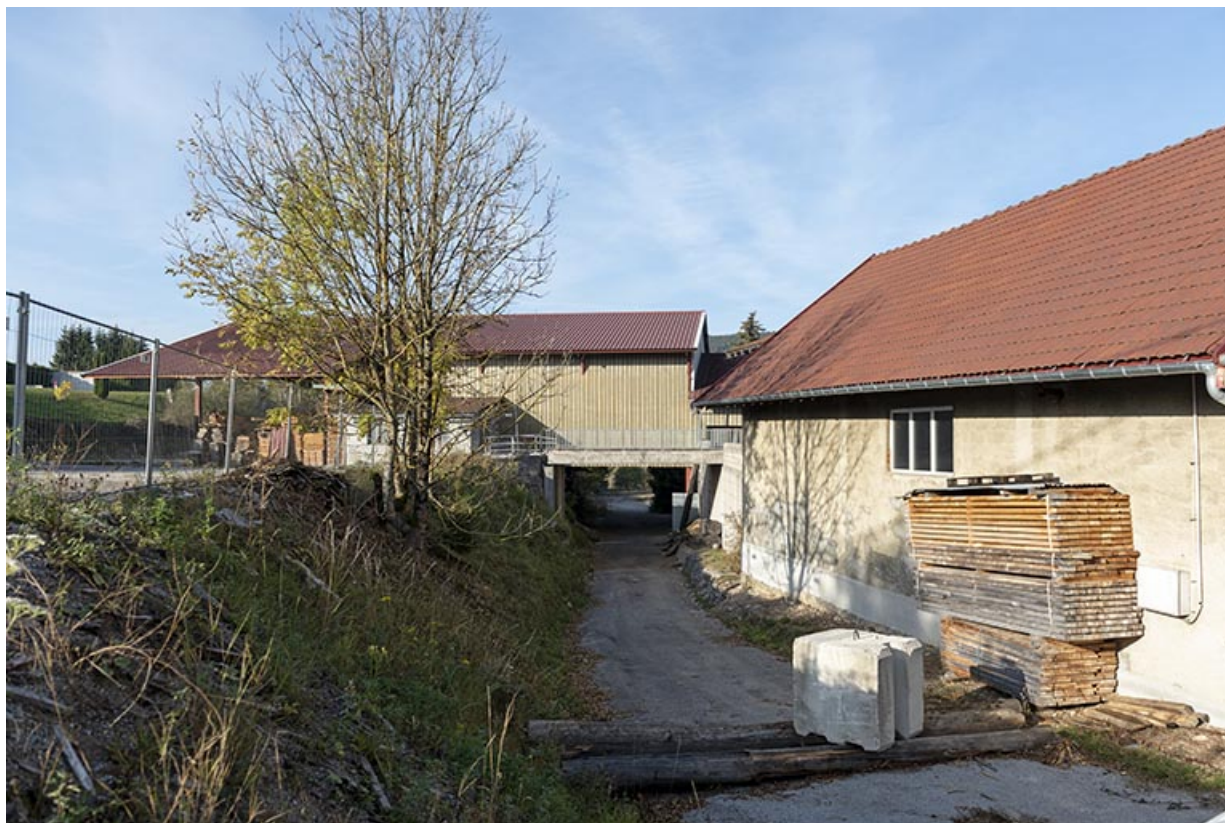
Atelier récent et chemin, depuis l'est.
