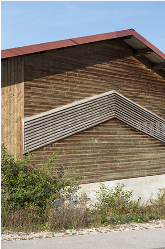
Magasin industriel : essentage de planches sur le mur est. 25, Les Fins, 1-3 route de Maîche
