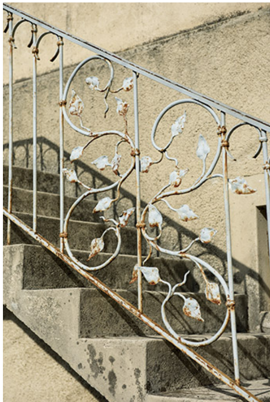
Maison de 1924 : ferronnerie du garde-corps de l'escalier. 25, Les Fins, lieudit : les Combes
