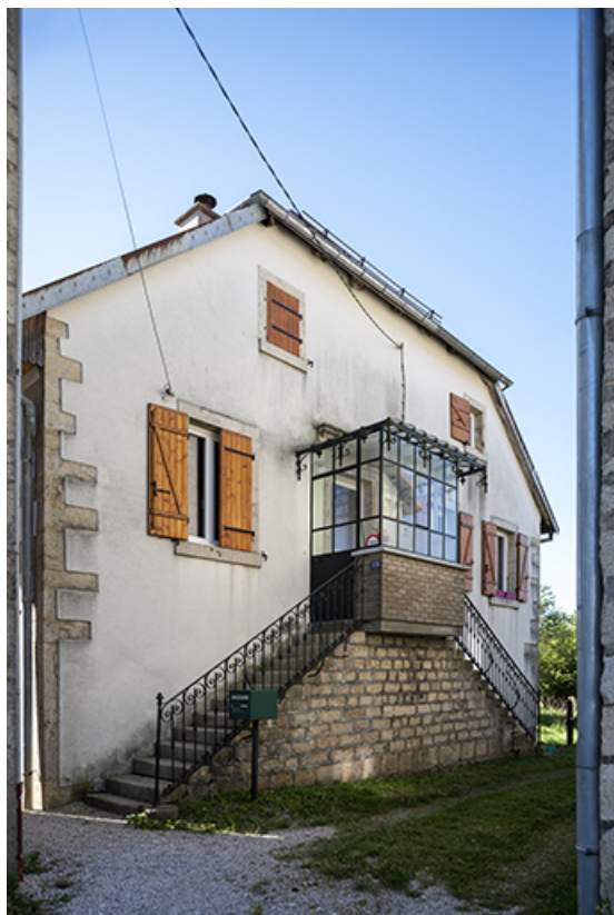
Grange : façade latérale droite, avec accès aux logements à l'étage. 25, Montécheroux, 49-53 Grande Rue
