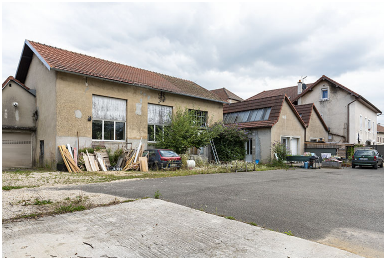
Usine : façade antérieure des ateliers, depuis la cour (à l'ouest). 25, Montécheroux, 1-3 rue de la Planchette
