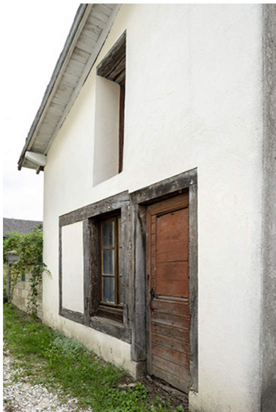
Atelier de fabrication : façade antérieure, vue en enfilade. 25, Montécheroux, 4-6 rue du Chêne
