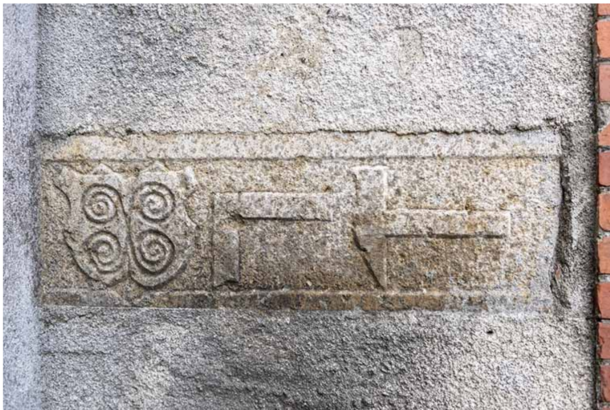
Atelier principal, façade antérieure : pierre sculptée en remploi.
