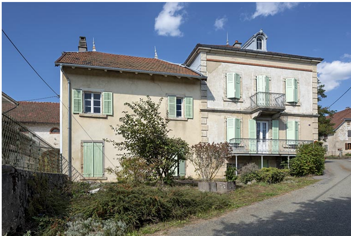
Magasin industriel et logement Hugoniot, depuis le sud. 25, Montécheroux, 5-7 rue du Chêne
