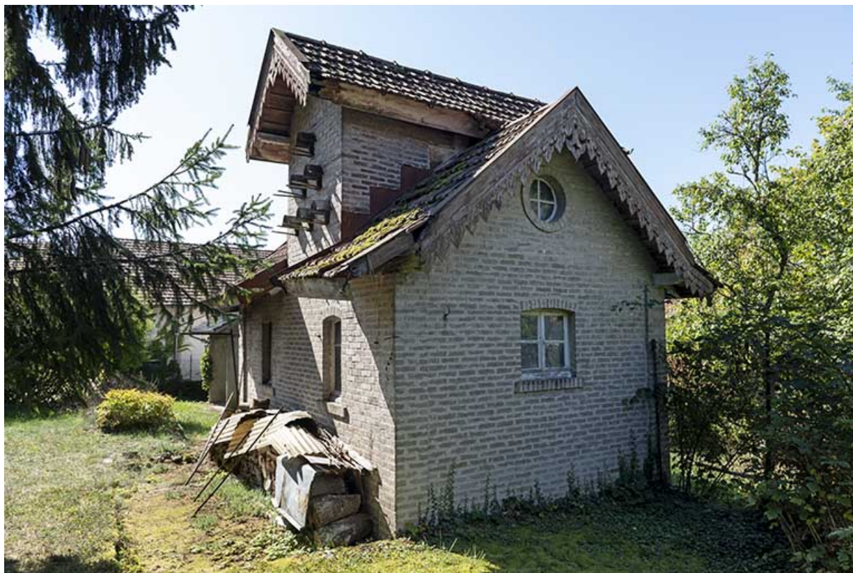
Pigeonnier : façade postérieure et latérale droite, de trois quarts.
