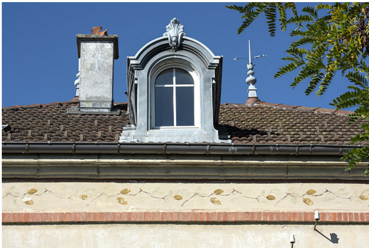
Logement Hugoniot : lucarne et décor peint sous la corniche.
