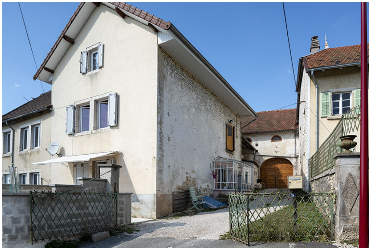
Logement de 1836, avec l'écurie en fond d'allée. 25, Montécheroux, 5-7 rue du Chêne
