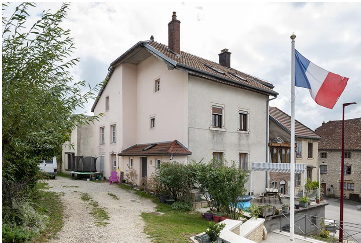
Bâtiment au 2 rue du Chêne, de trois quarts gauche. 25, Montécheroux, 8-10 Grande Rue
