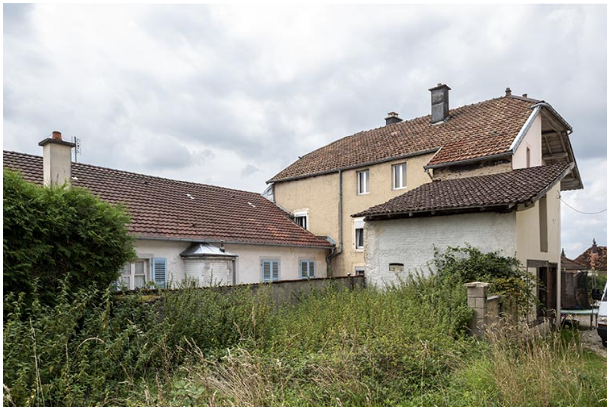
Bâtiment au 2 rue du Chêne : façade postérieure. 25, Montécheroux, 8-10 Grande Rue
