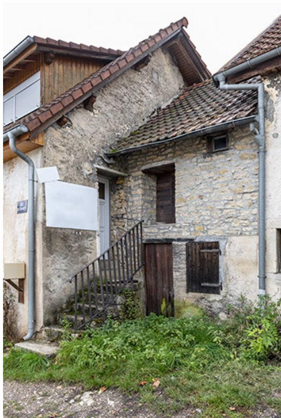
Forge : façade antérieure, sur la rue de Saint-Hippolyte. 25, Montécheroux
