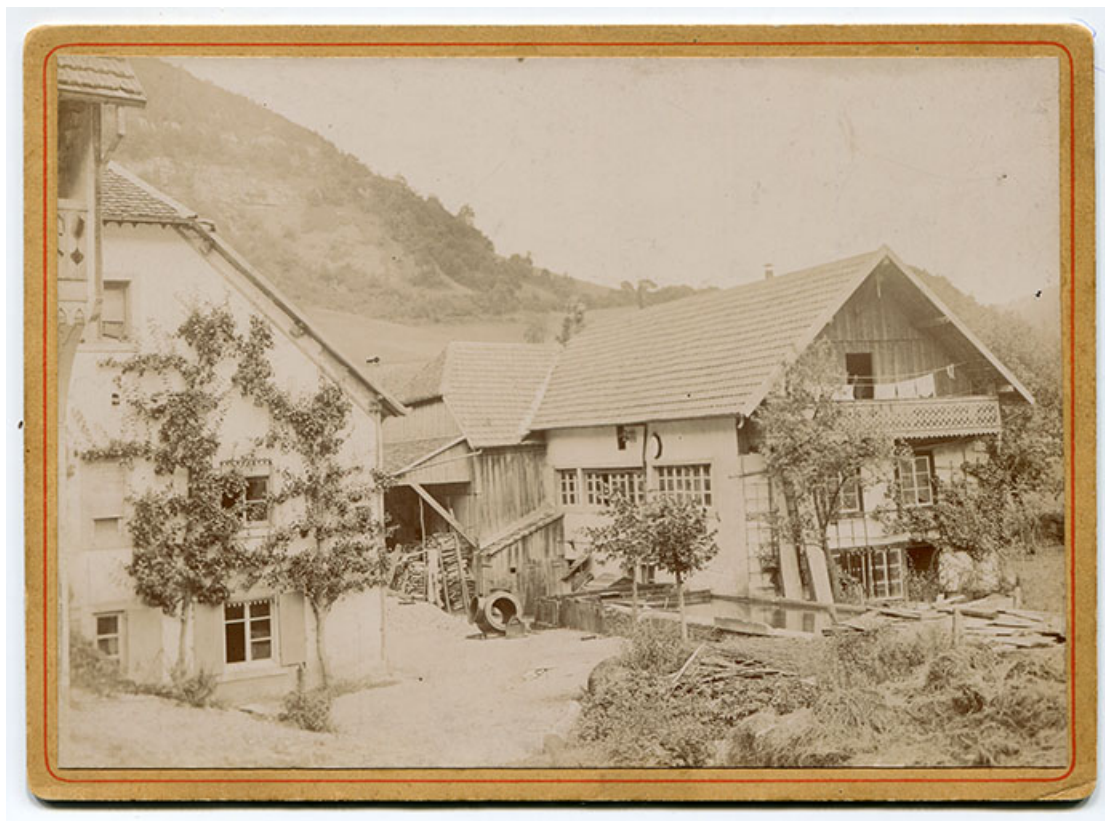
[Vue d'ensemble de l'atelier], 1er quart 20e siècle ? 25, Rosureux, 1-3 impasse de la Truite
