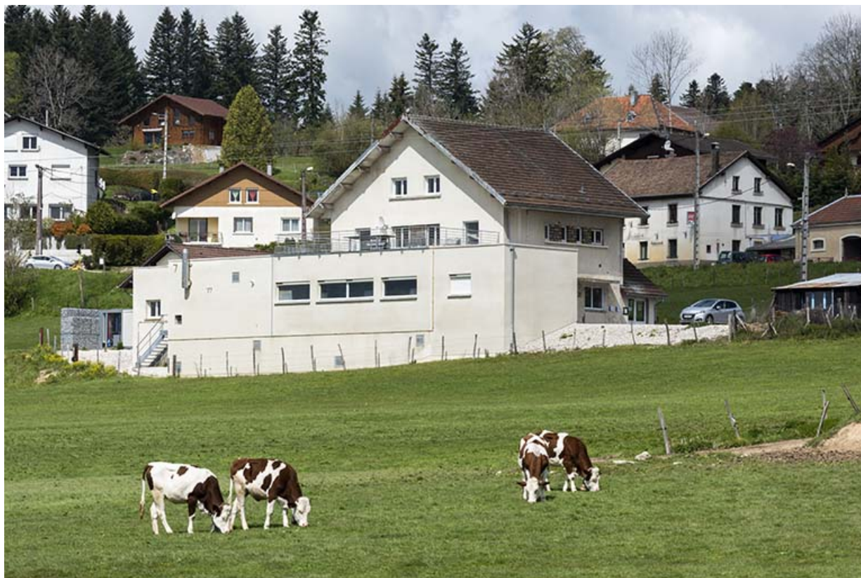
Vue d'ensemble, depuis l'est (façades postérieure et latérale gauche). 25, Les Fontenelles, 2 rue de la Gare
