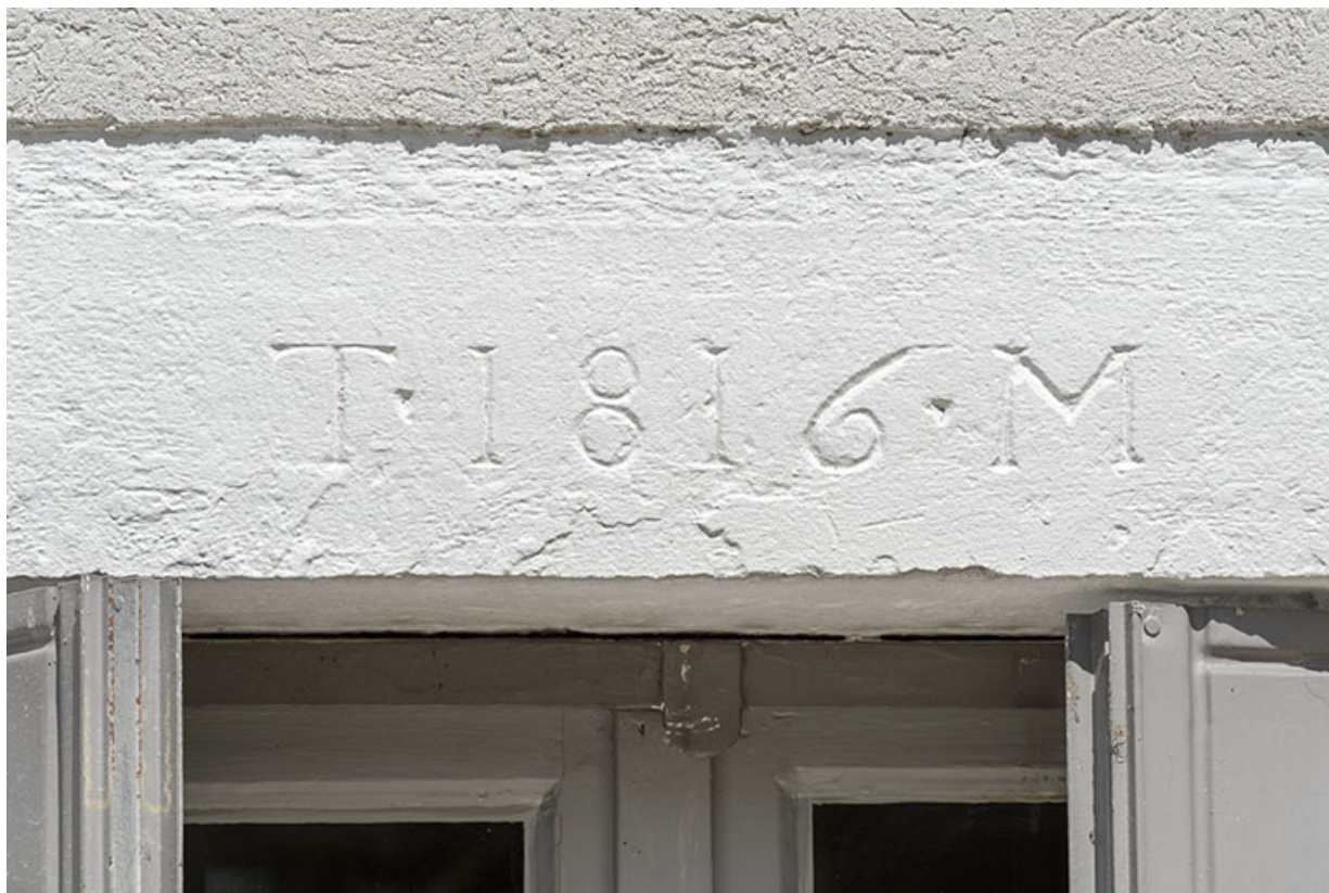
Ancienne ferme, façade antérieure : linteau daté 1816.
