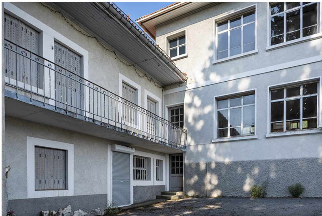
Ancienne ferme : façade postérieure et jonction avec l'atelier de 1930.
