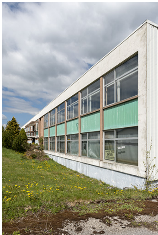
Façade antérieure, vue en enfilade.
