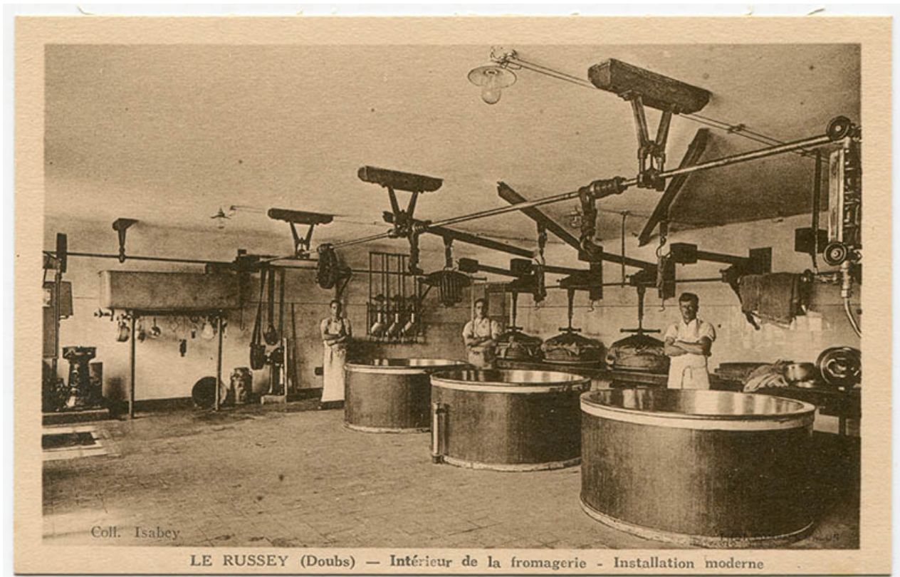
Le Russey (Doubs) - Intérieur de la fromagerie - Installation moderne [avec les trois fromagers, chacun derrière une cuve], 2e quart 20e siècle.
