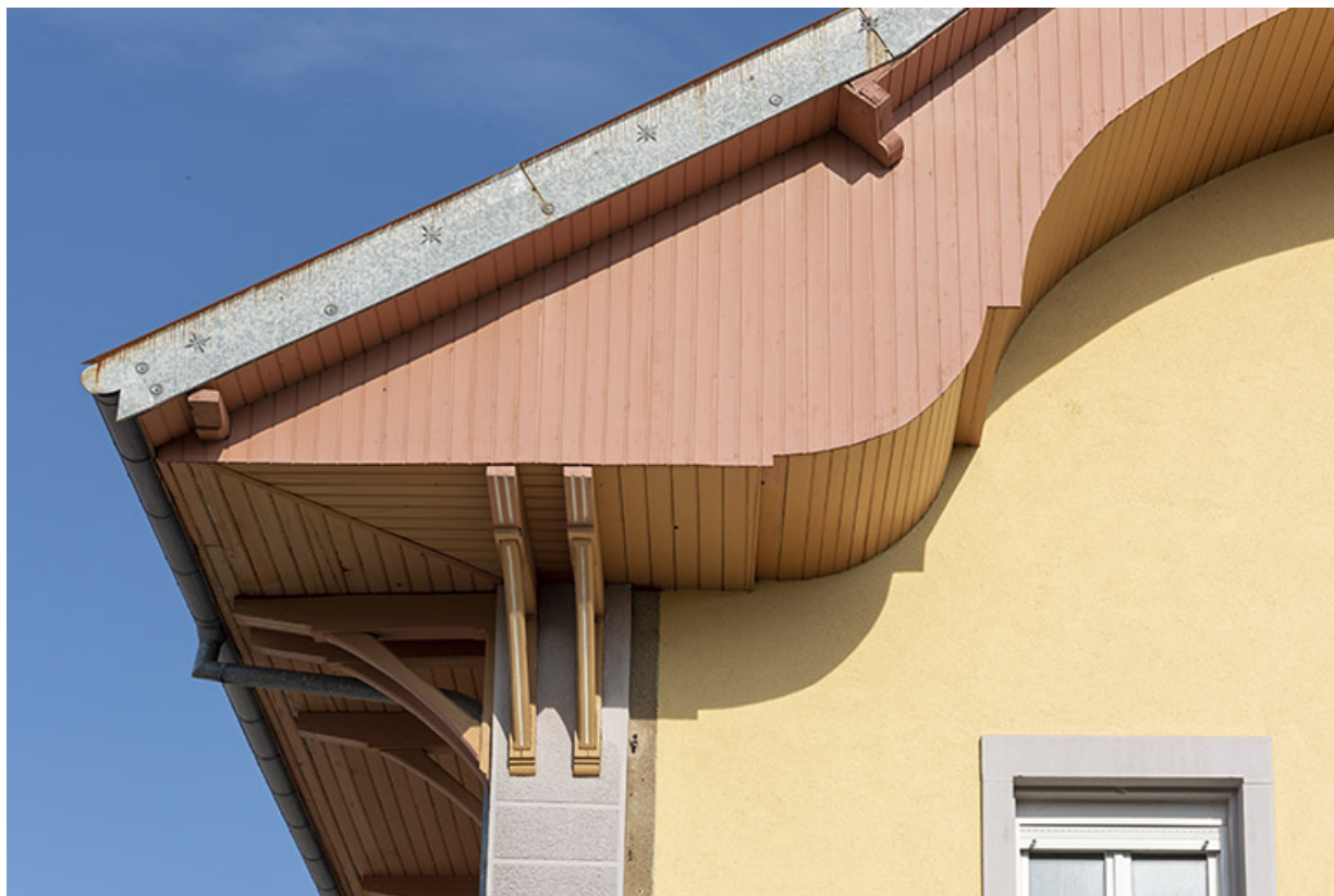
Façade latérale droite : détail de l'avant-toit et de ses consoles.
