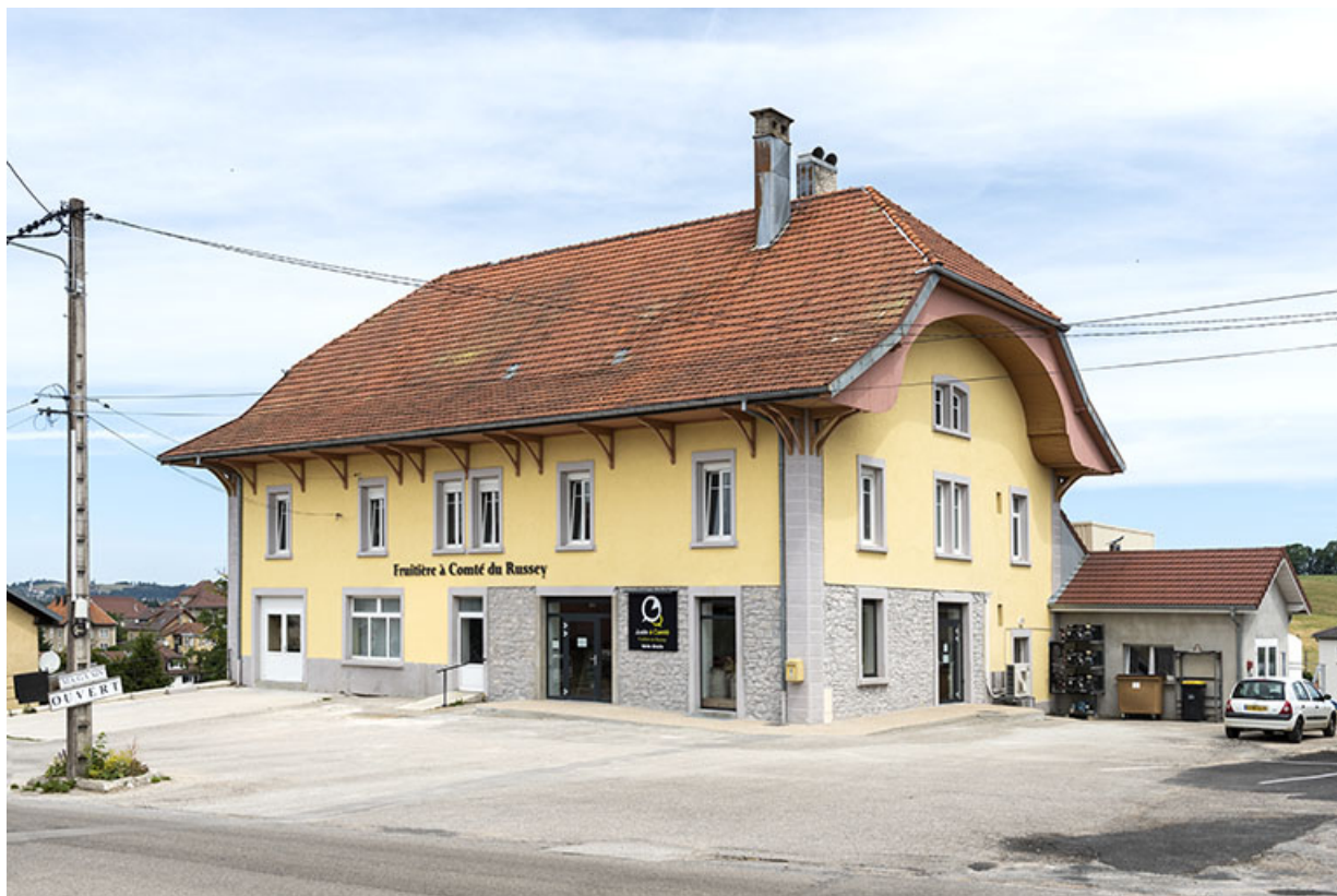
Façades antérieure et latérale droite (après rafraîchissement).
