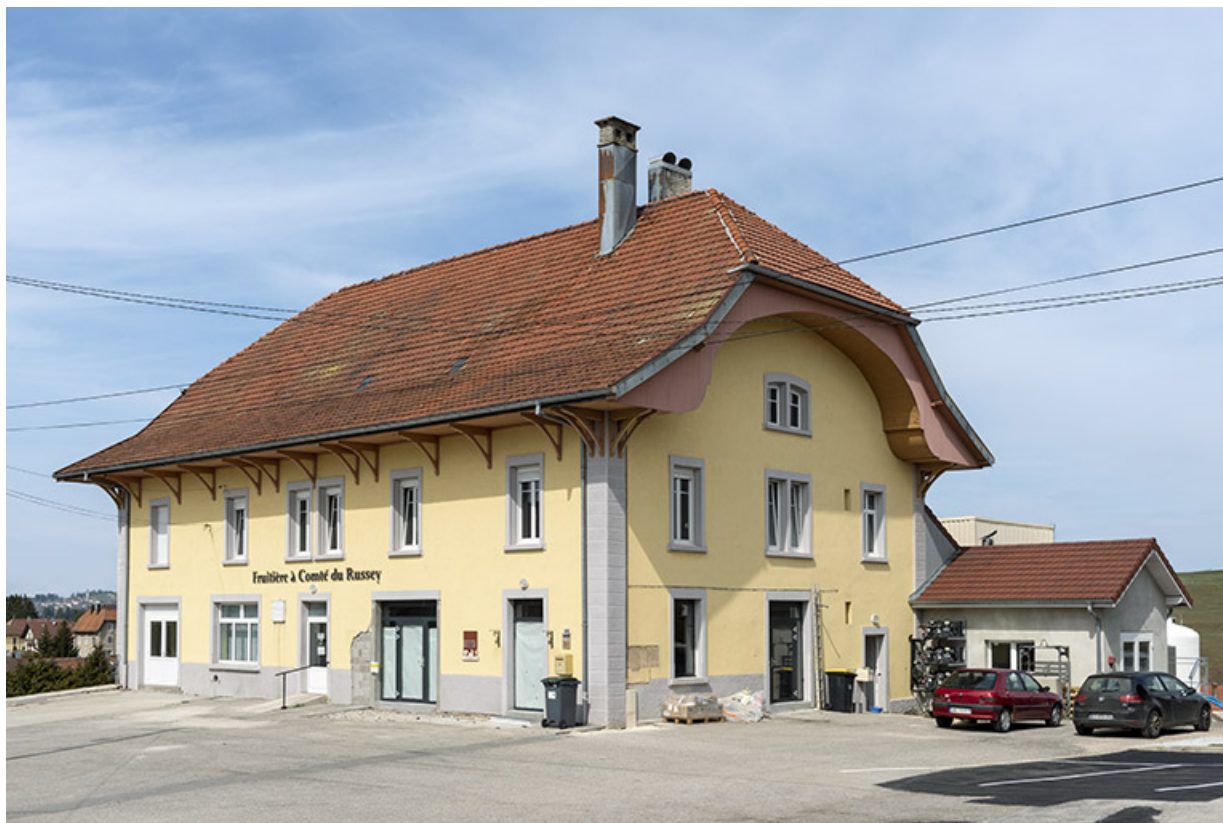
Façades antérieure et latérale droite.
