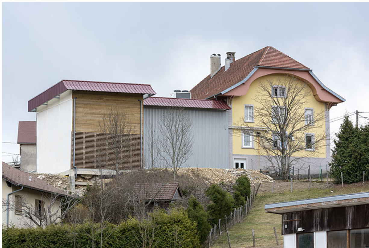
Façade latérale gauche et extension, depuis l'ouest.
