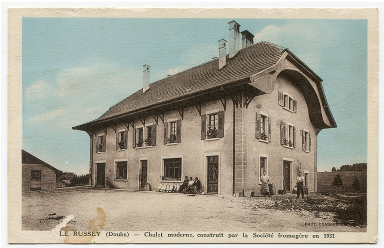
Le Russey (Doubs) - Chalet moderne, construit par la Société fromagère en 1931, entre 1931 et 1938.
