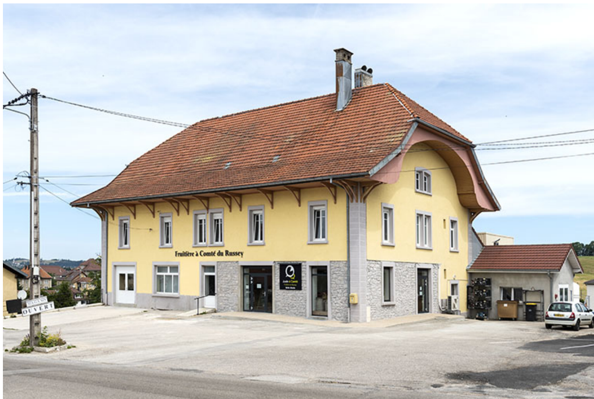
Façades antérieure et latérale droite (après rafraîchissement).
