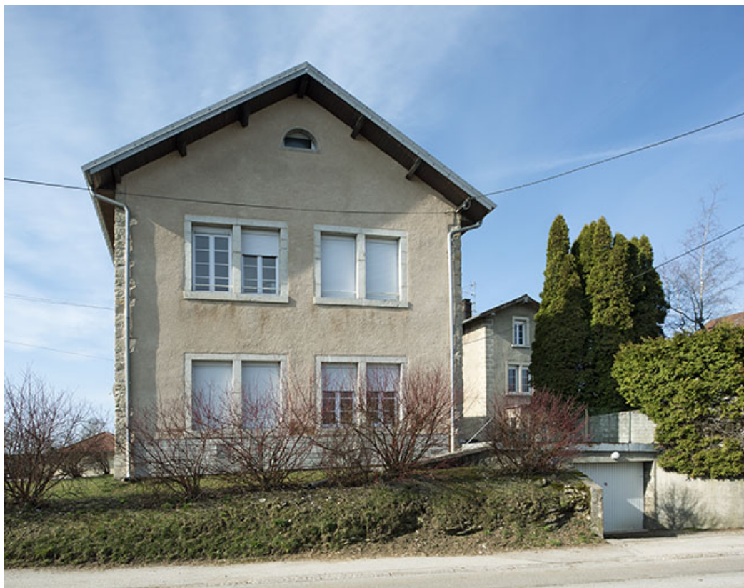
Atelier de fabrication : façade nord.
