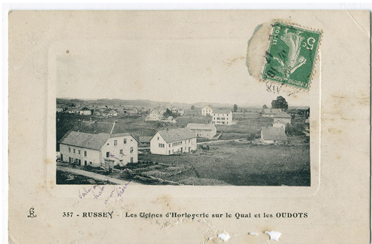
357 - Russey - Les usines d'horlogerie sur le Quai et les Oudots, 1er quart 20e siècle [entre 1911 et 1919]. 25, Le Russey, 5 rue Leclerc
