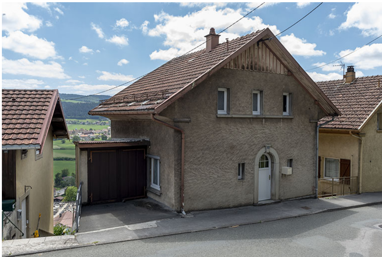
Façades antérieure et latérale gauche.
