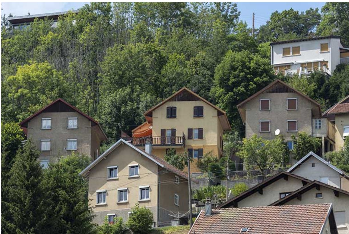
Vue d'ensemble depuis le sud-est (côté vallée) : maison à droite au deuxième plan.
