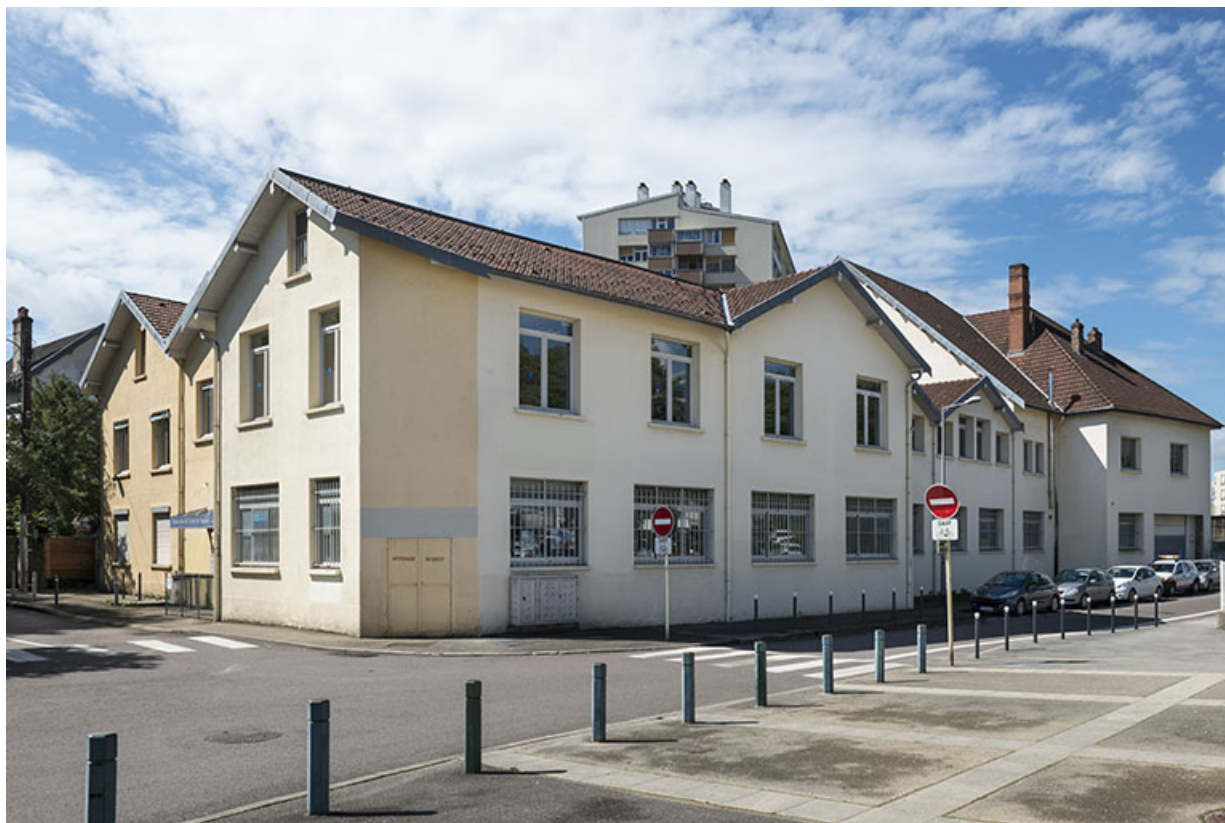
Façades nord sur la rue Violet. Vue de trois quarts gauche.
