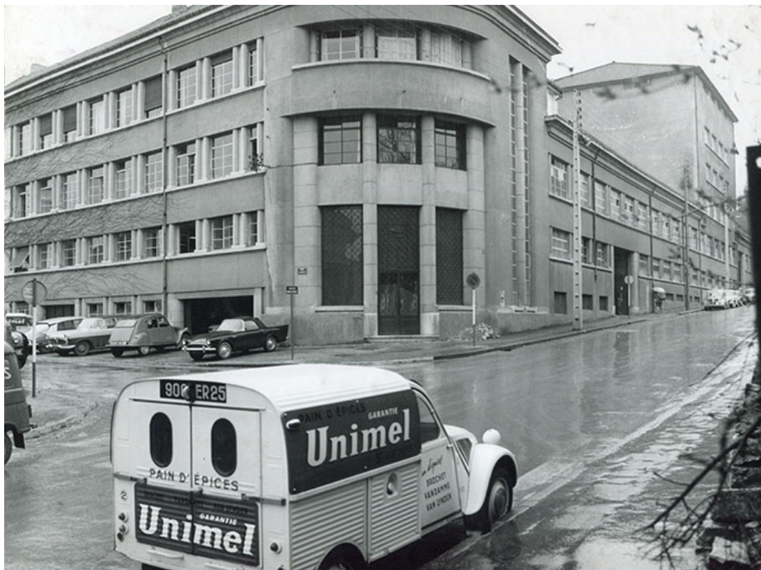
Vue d'ensemble de l'usine, s.d. [1963]. 25, Besançon, 33, 35 rue de Vesoul
