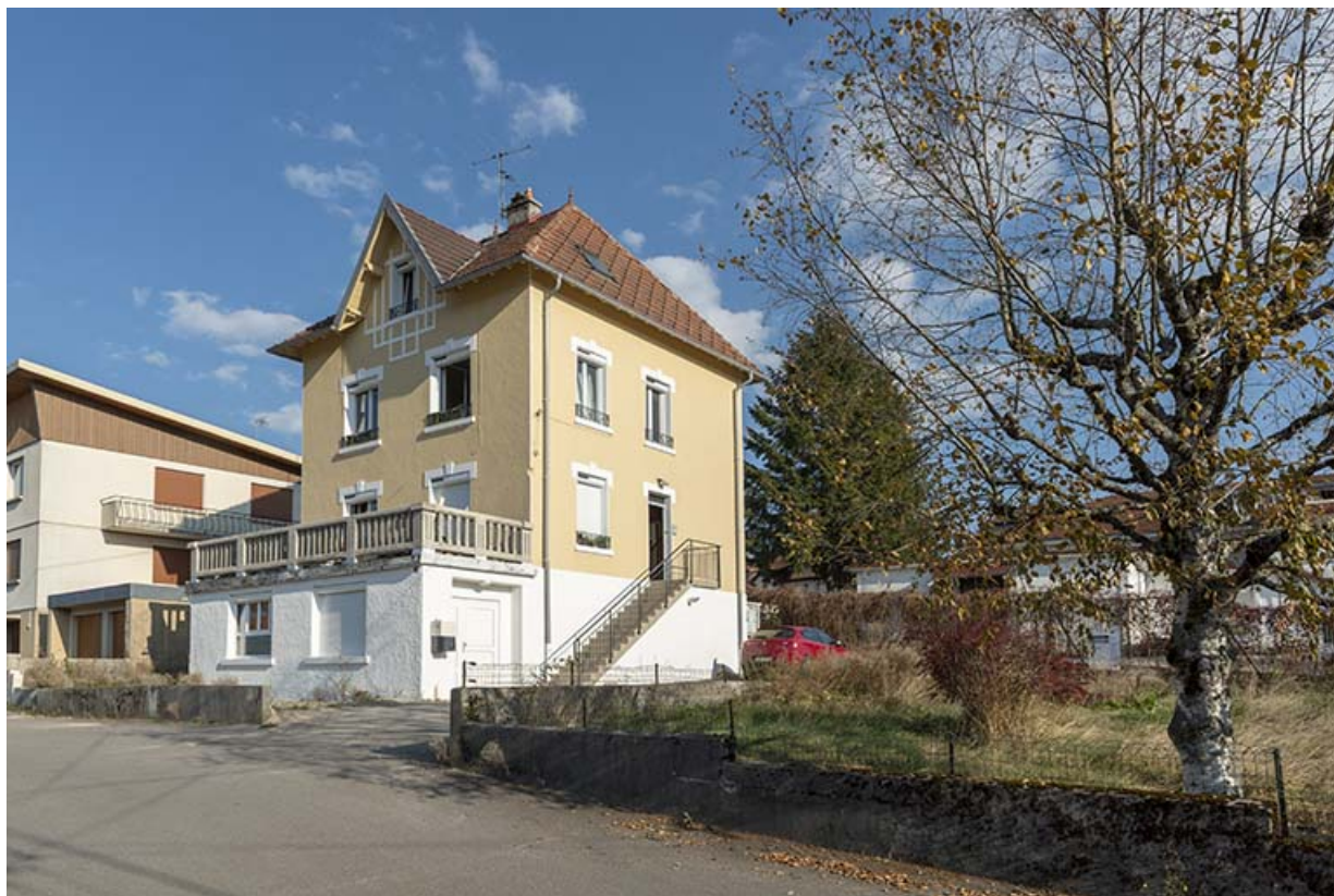
Façades antérieure et latérale droite.
