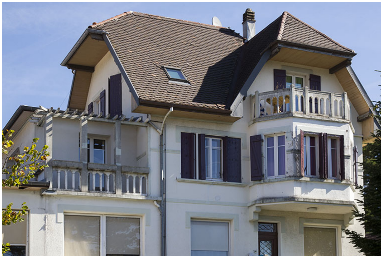
Maison : étage et étage en surcroît, de trois quarts gauche. 25, Morteau, 14 rue Victor Hugo
