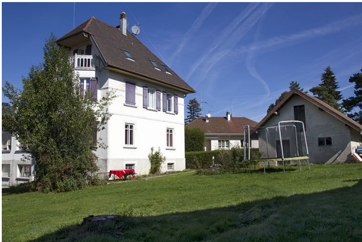
Maison (façade latérale droite) et garage.
