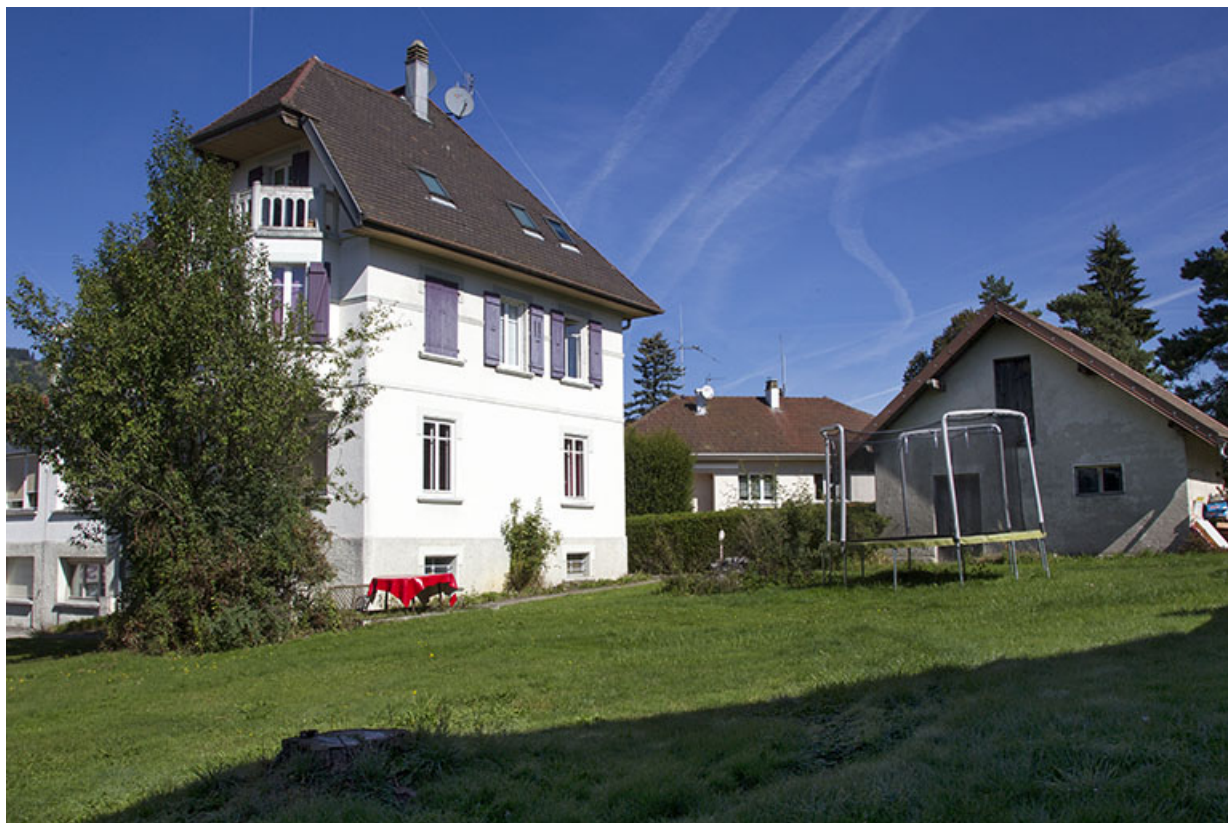
Maison (façade latérale droite) et garage.
