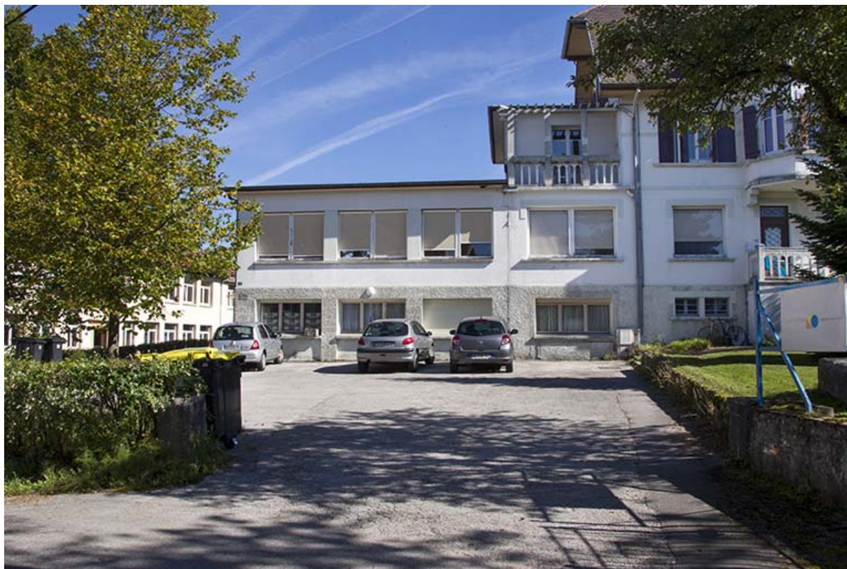
Usine : façade antérieure.
