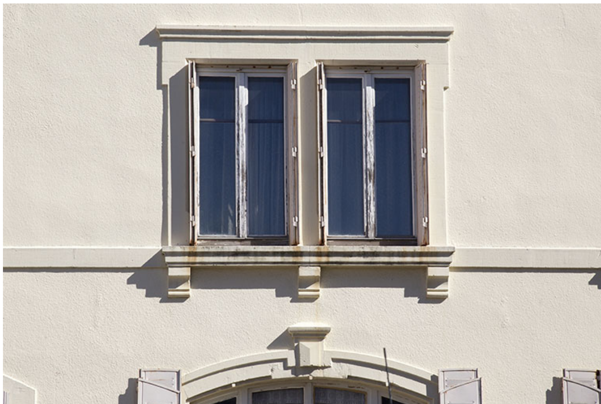
Façade antérieure : fenêtres jumelées au premier étage.
