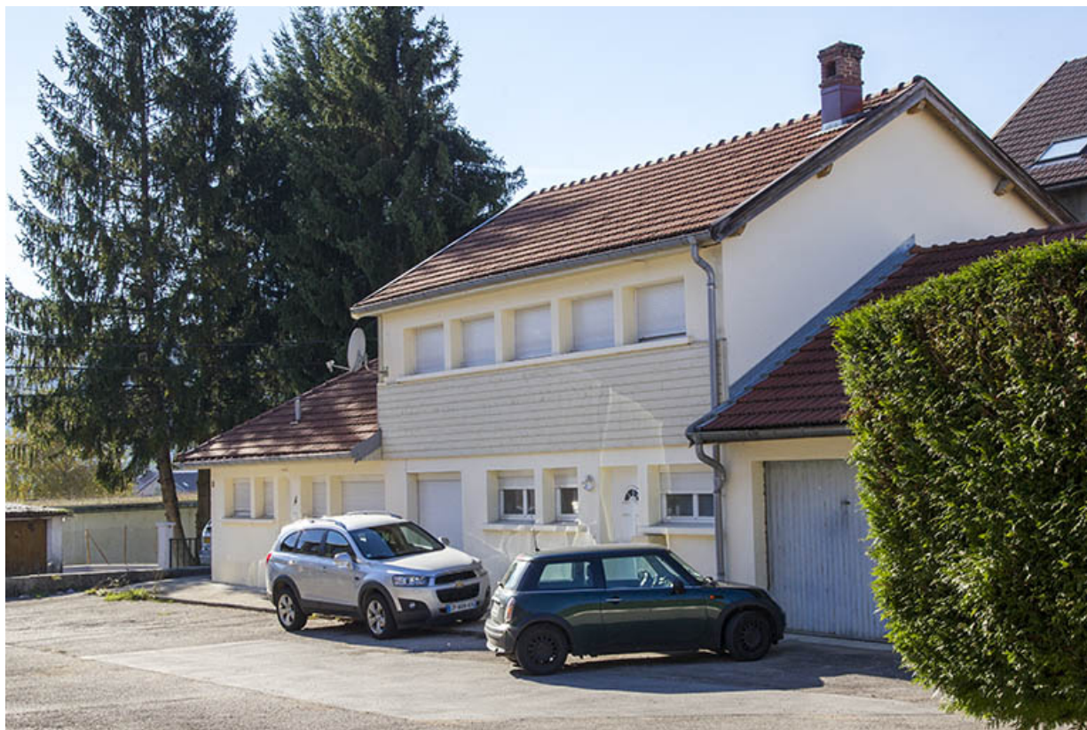
Bâtiment sur cour, de trois quarts droite.
