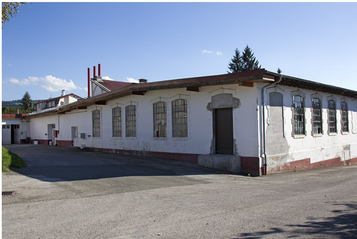
Bâtiments sud : façades postérieure et latérale droite.
