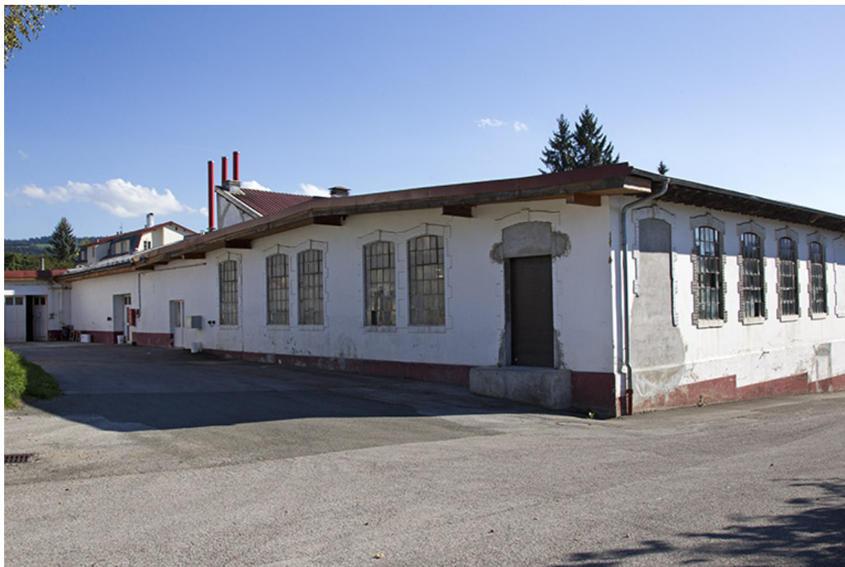
Bâtiments sud : façades postérieure et latérale droite.
