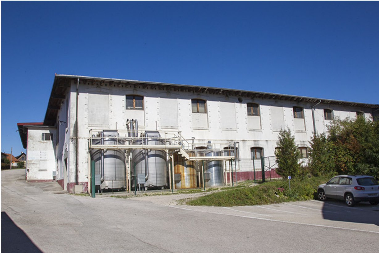
Bâtiments sud : façade latérale gauche.
