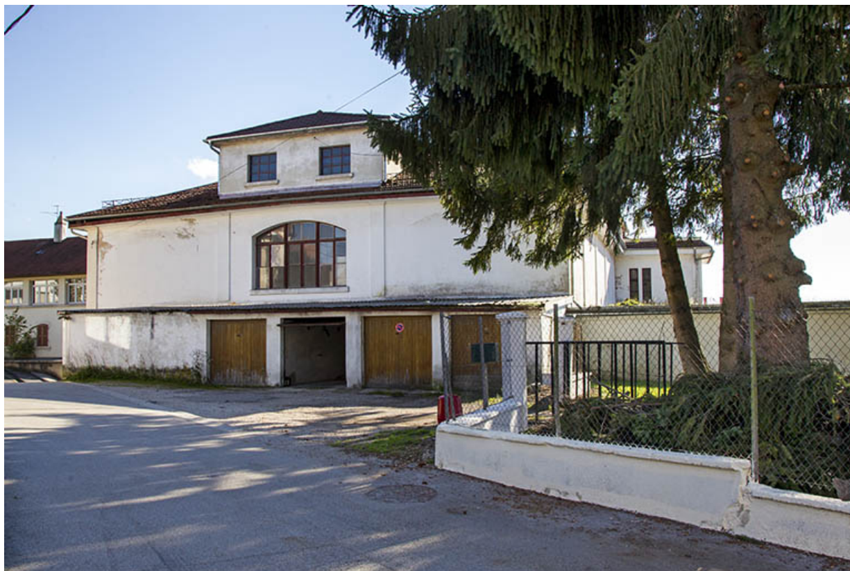
Bâtiment nord : façade latérale droite.
