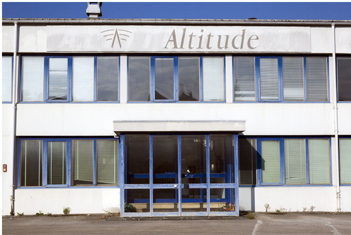
Bâtiment à étage : travées centrales de la façade orientale.
