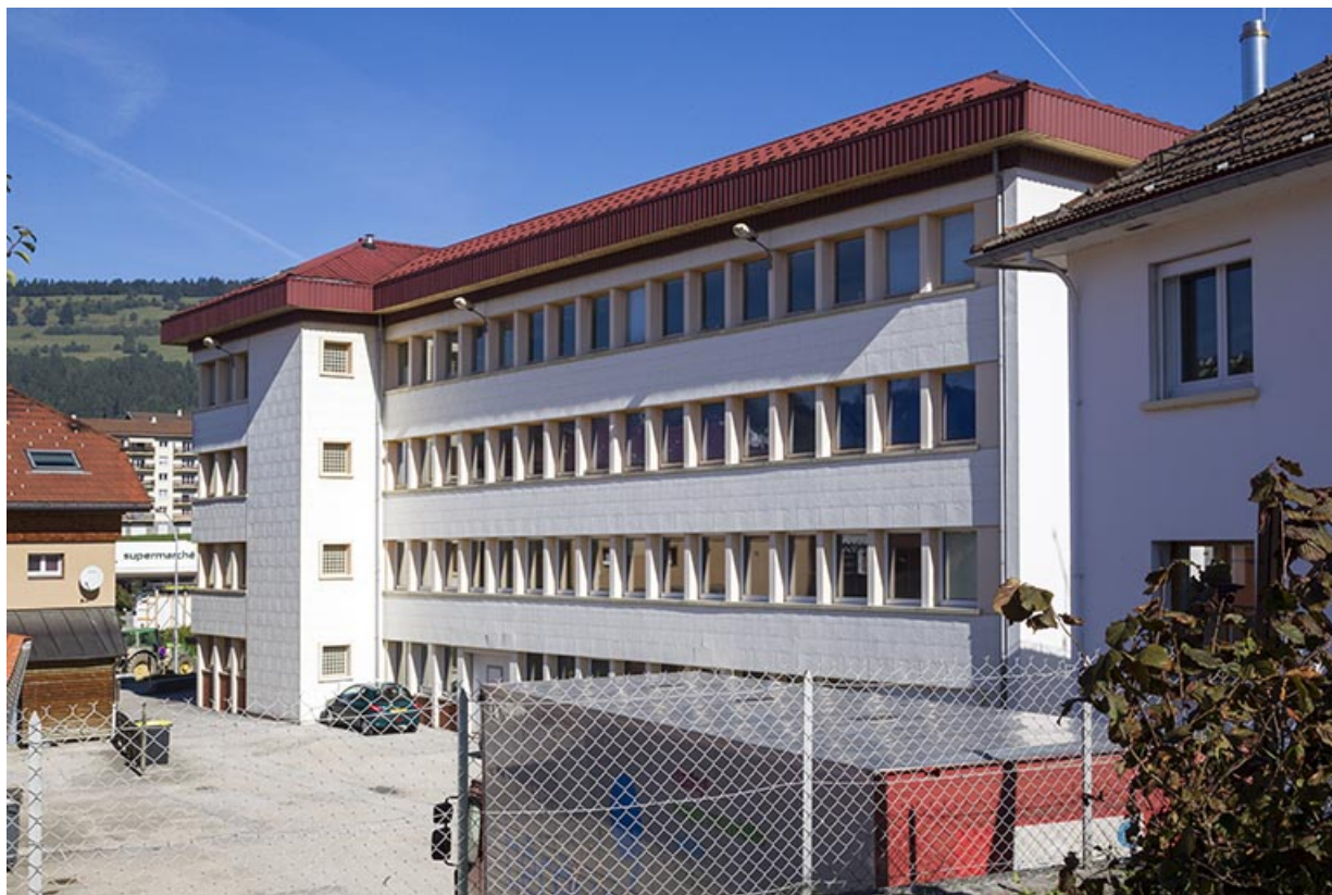
Usine : façade latérale droite, vue en enfilade.
