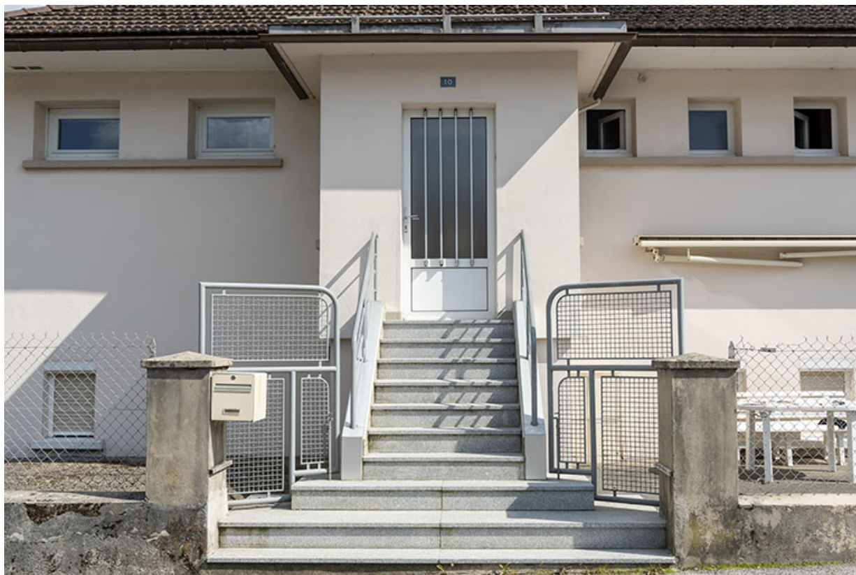
Maison au n° 10 rue Emile Cattin : escalier et entrée.
