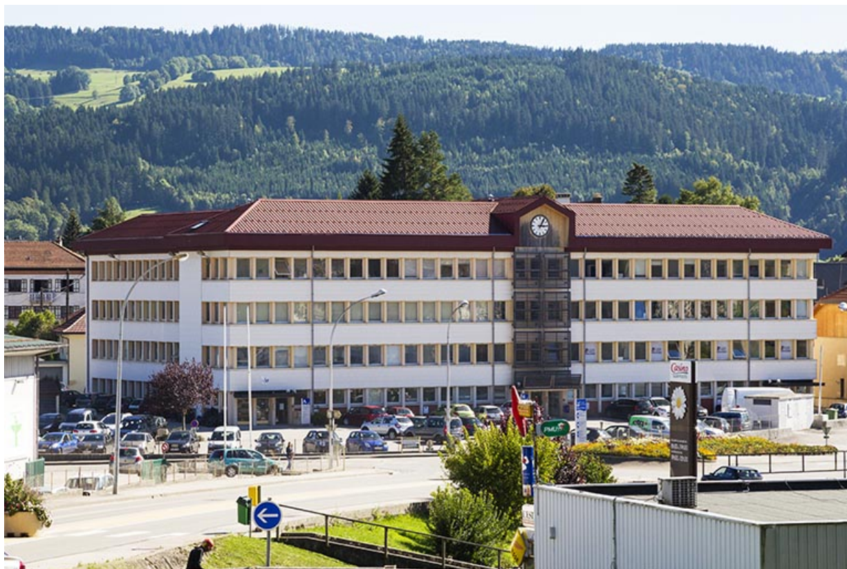
Usine : façades antérieure et latérale gauche. 25, Morteau, 8 avenue Charles de Gaulle
