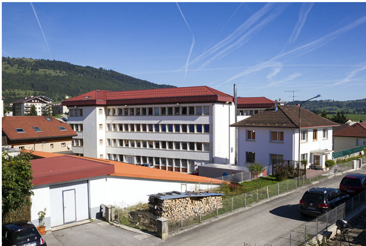
Vue d'ensemble, depuis la rue Emile Cattin au sud-ouest (maison et façade latérale droite de l'usine). 25, Morteau, 8 avenue Charles de Gaulle
