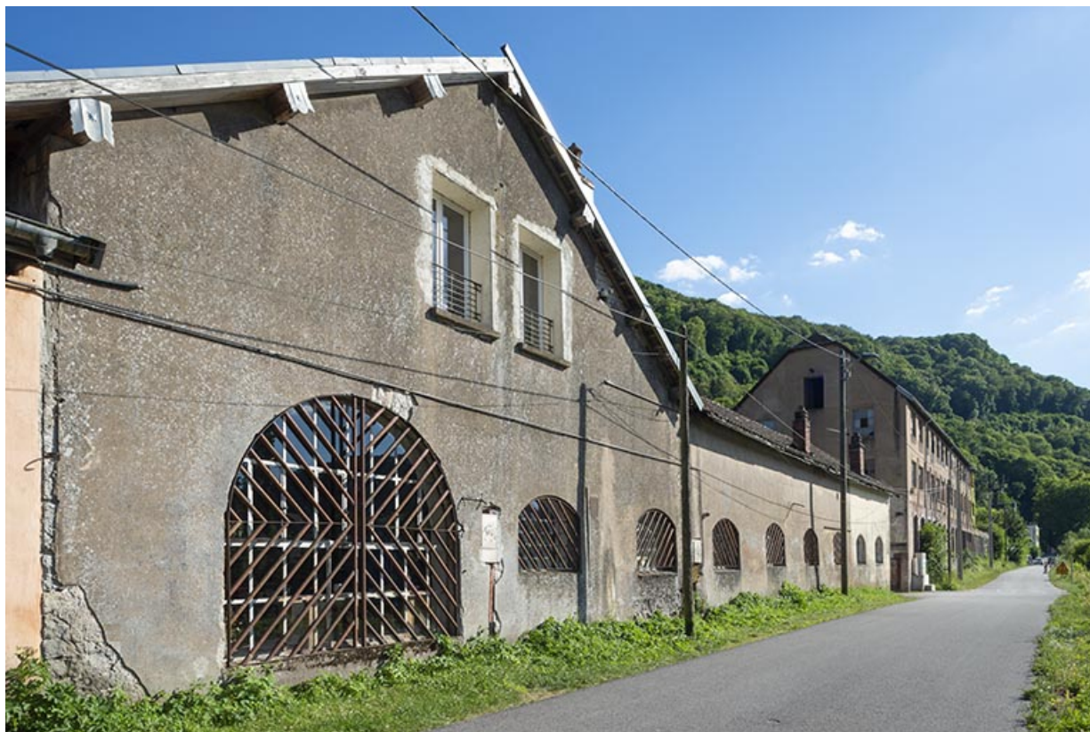
Alignement des bâtiments de la faïencerie et du tissage le long du chemin de halage.
