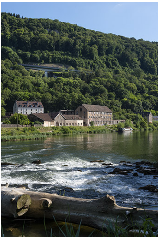
Vue d'ensemble depuis le nord-est (cadrage vertical).
