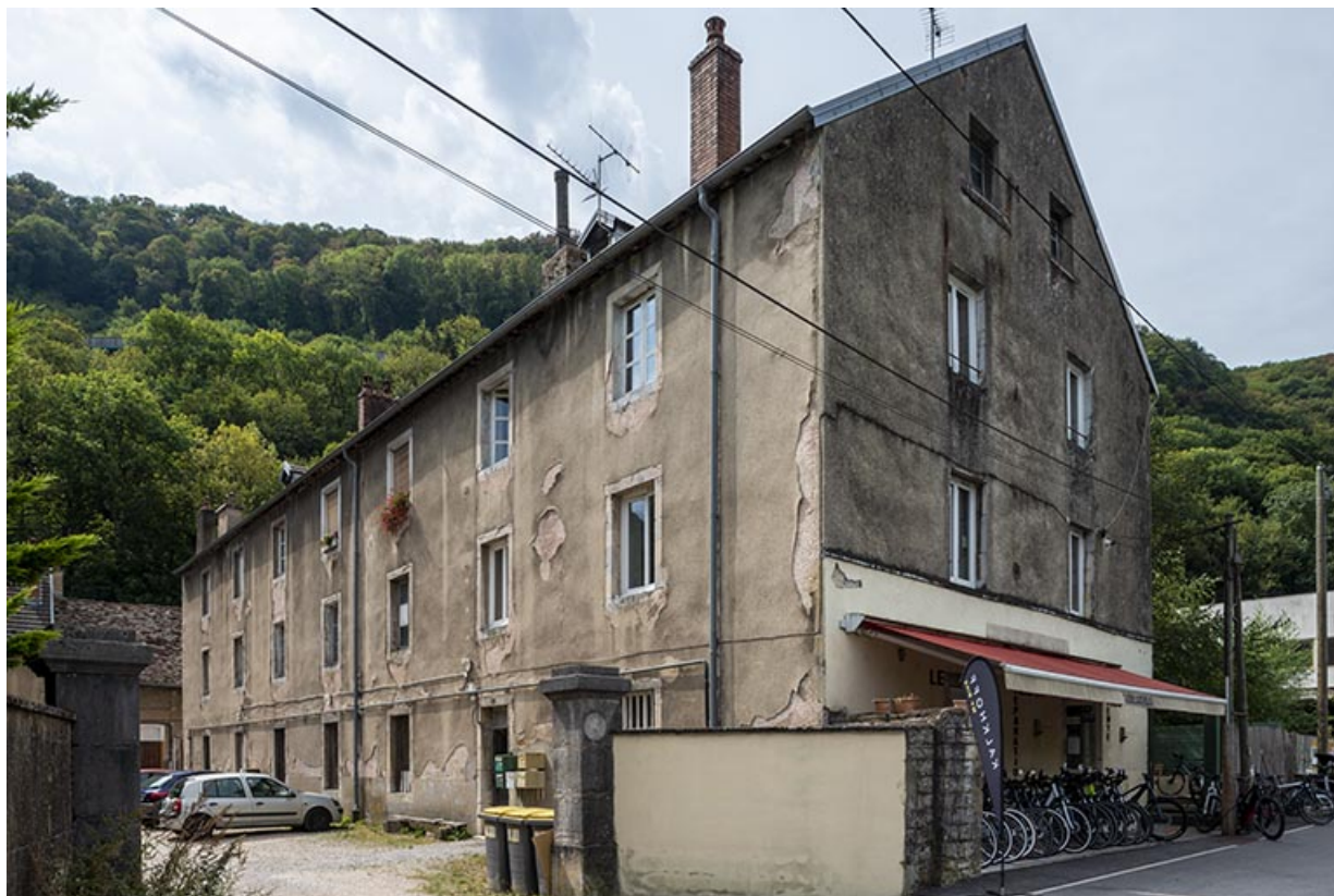
Logement ouvrier vu de trois quarts, depuis le chemin de halage. 25, Besançon avenue de la 7e Armée américaine, lieudit : Casamène
