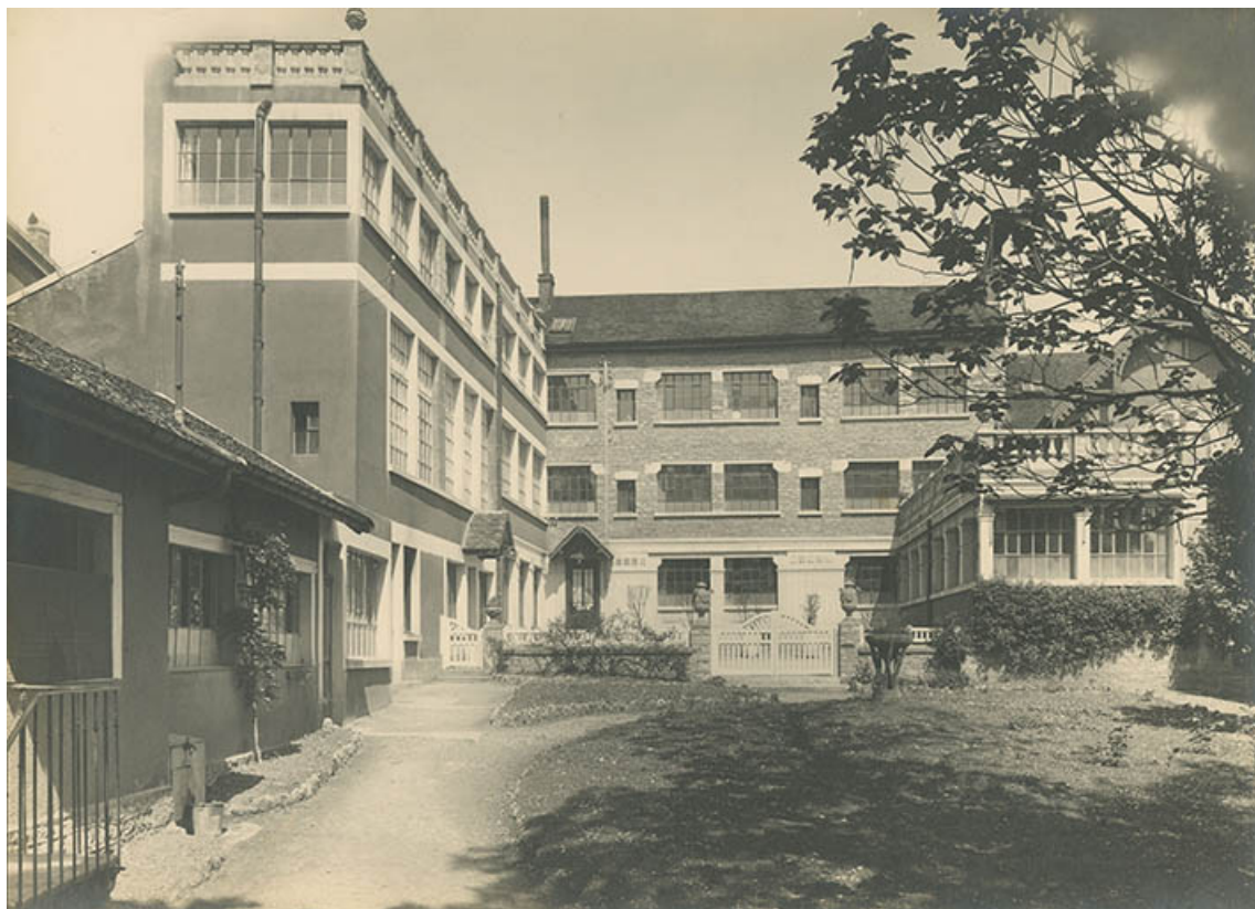
Vue d'ensemble des ateliers, 1933.
