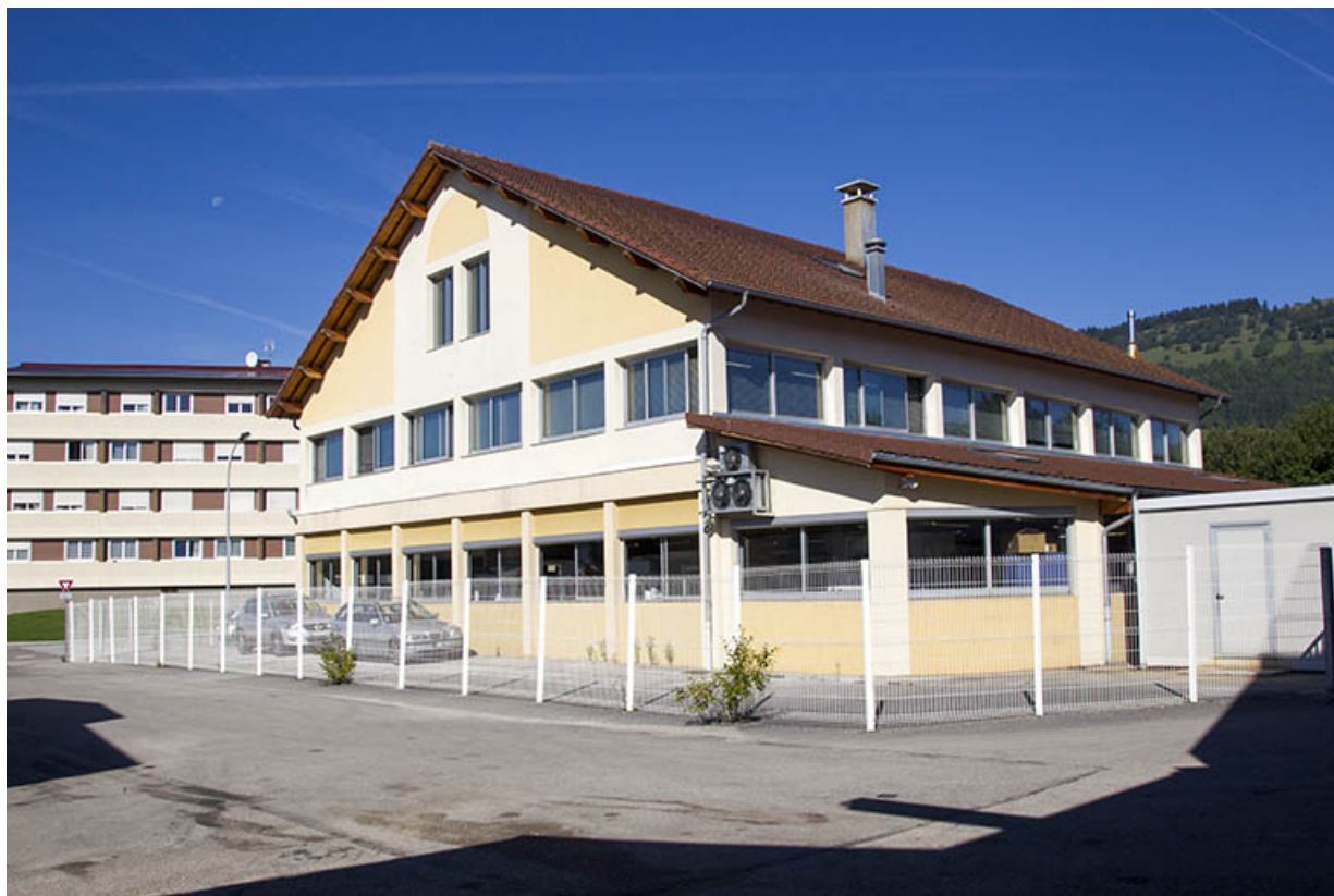
Façades postérieure et latérale droite.
