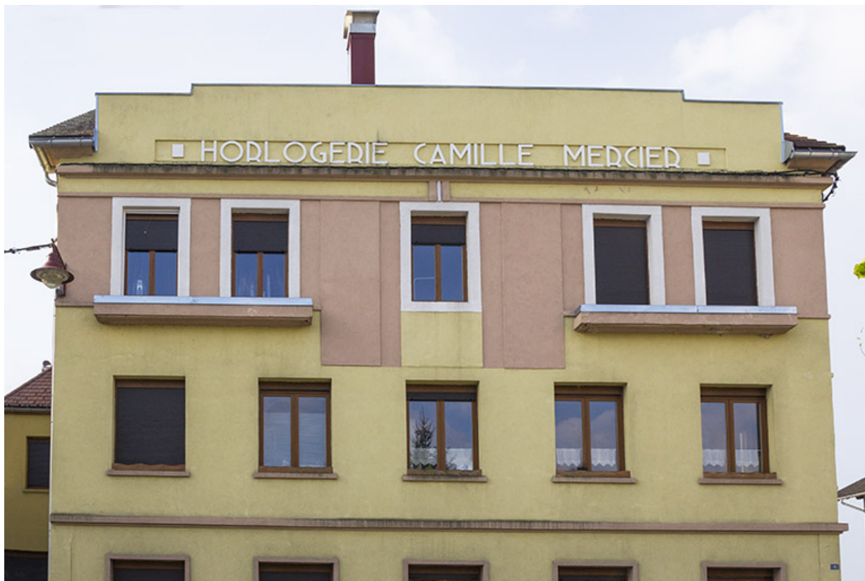
Immeuble : façade antérieure (étages). 25, Morteau, 8 rue de l' Helvétie
