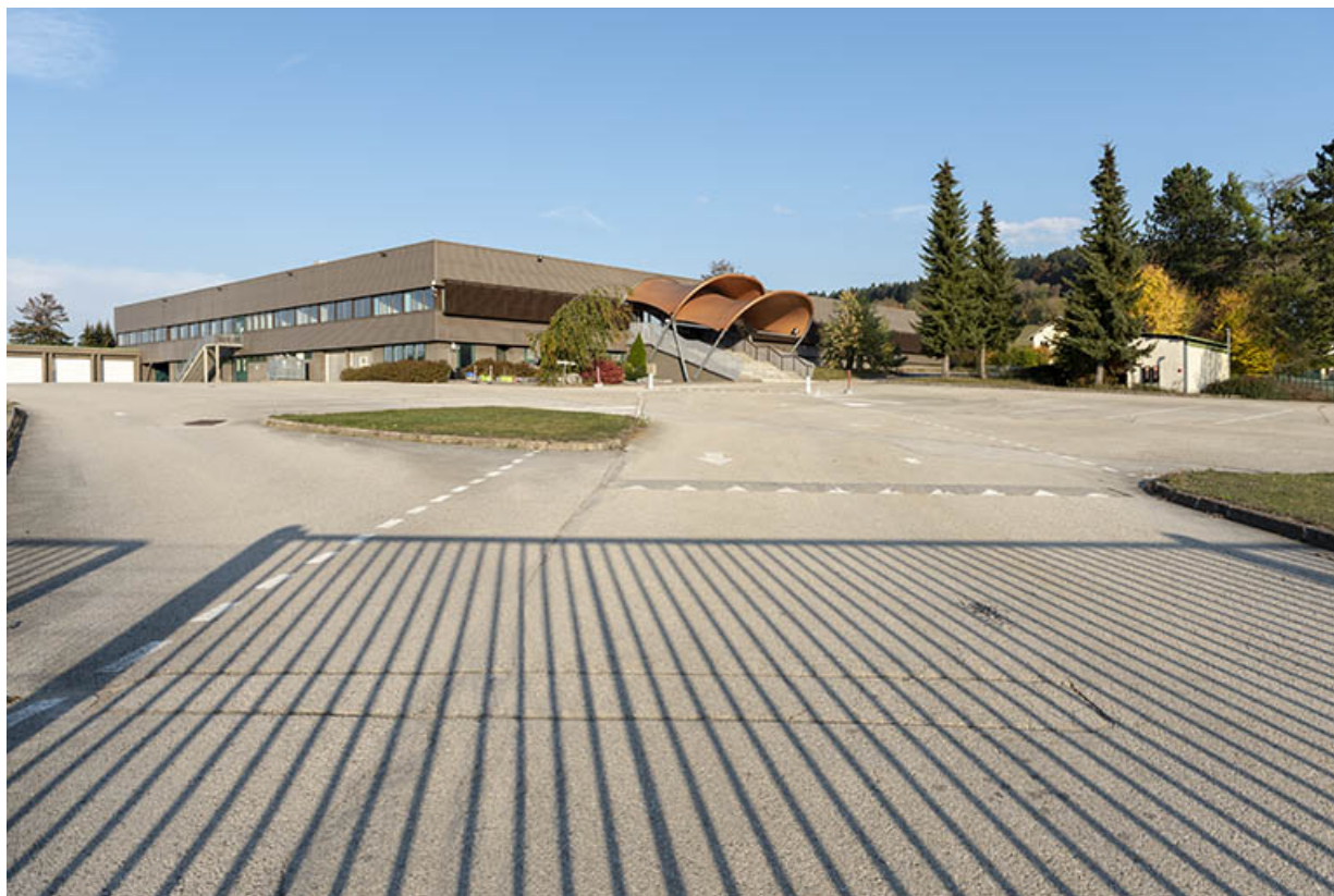
Vue d'ensemble, depuis l'entrée au sud-ouest.
