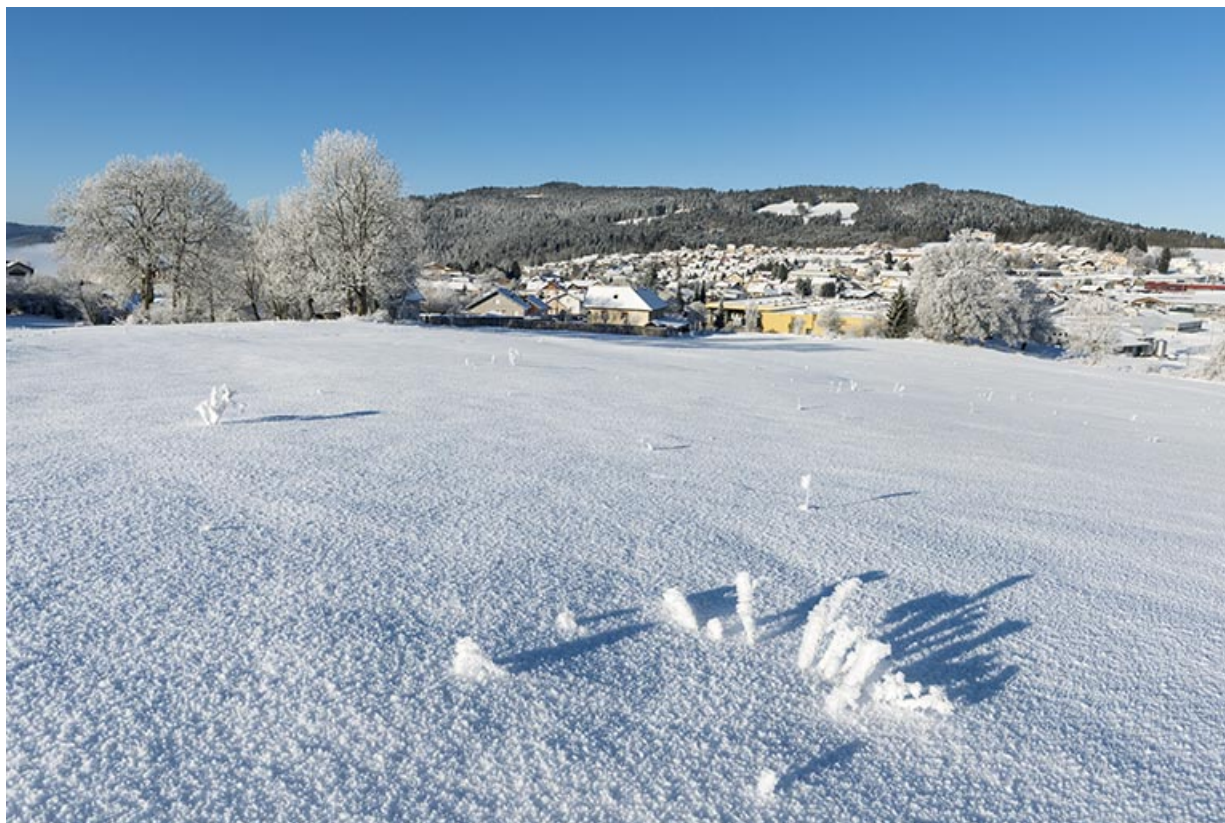
Vue d'ensemble éloignée du site, en hiver, depuis l'est. L'usine se distingue par sa couleur jaune.
