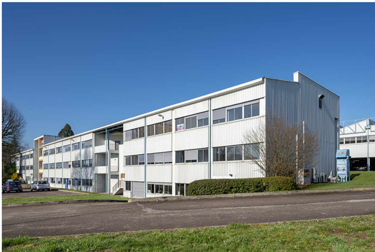
Vue de trois quarts du bâtiment abritant les services administratifs, le service après-vente et les ateliers de montage. 25, Besançon chemin de Palente
