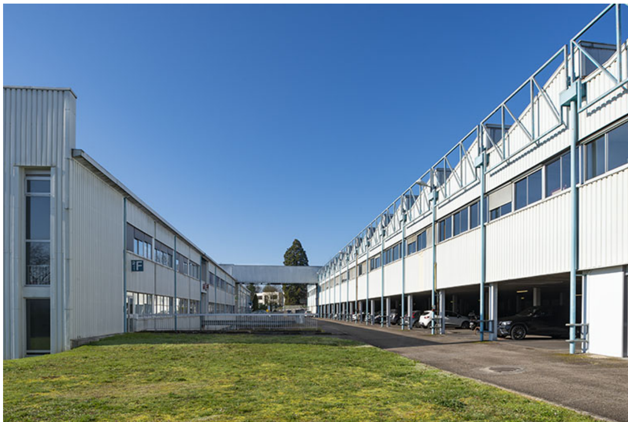
Passage entre le bâtiment administratif et l'atelier de fabrication. Vue depuis le nord. 25, Besançon chemin de Palente
