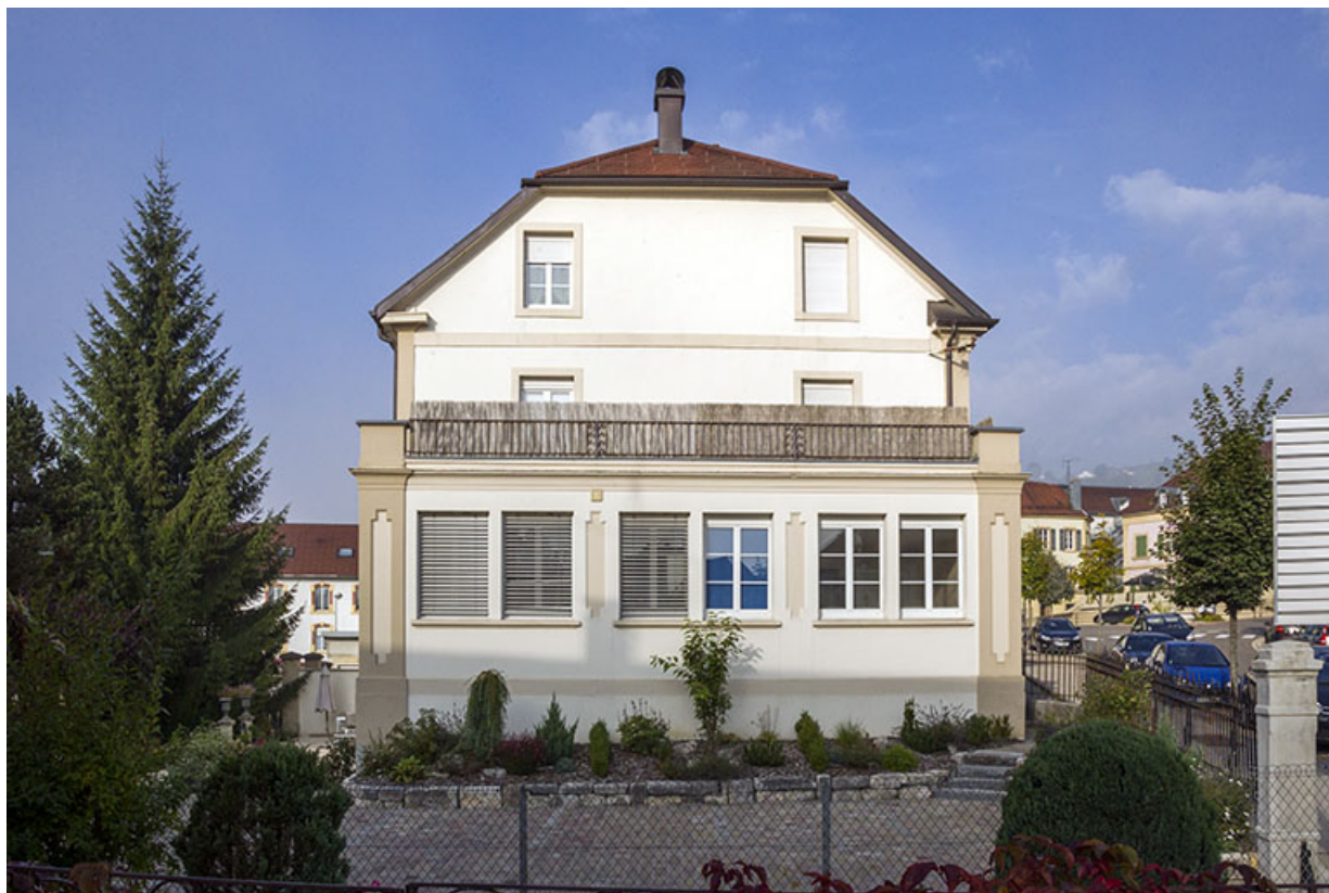
Façade latérale gauche, avec l'atelier.
