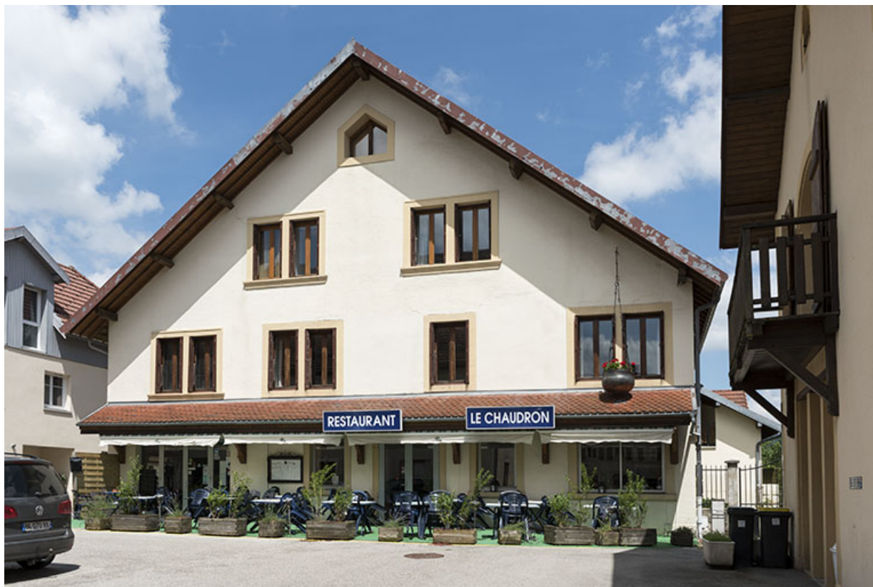
Ancienne ferme et atelier Seguin. 25, Morteau, 18-22 Grande Rue
