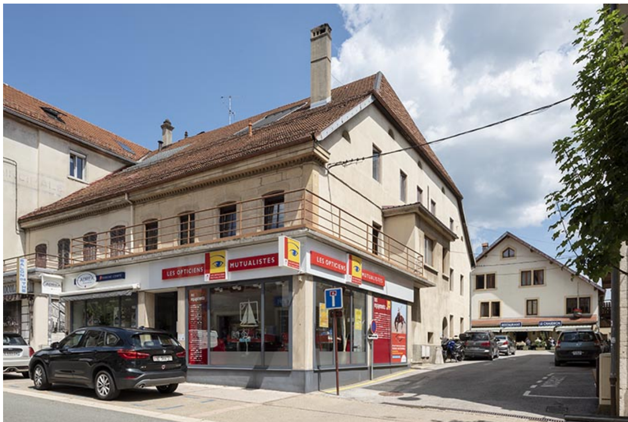
Vue d'ensemble du site, depuis la Grande Rue : maison à gauche, ancienne ferme à droite. 25, Morteau, 18-22 Grande Rue
