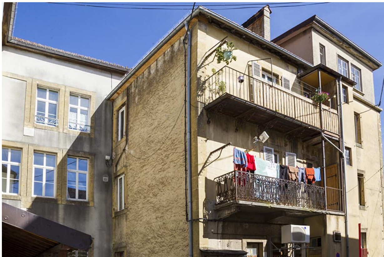
Façades postérieure et latérale droite.
